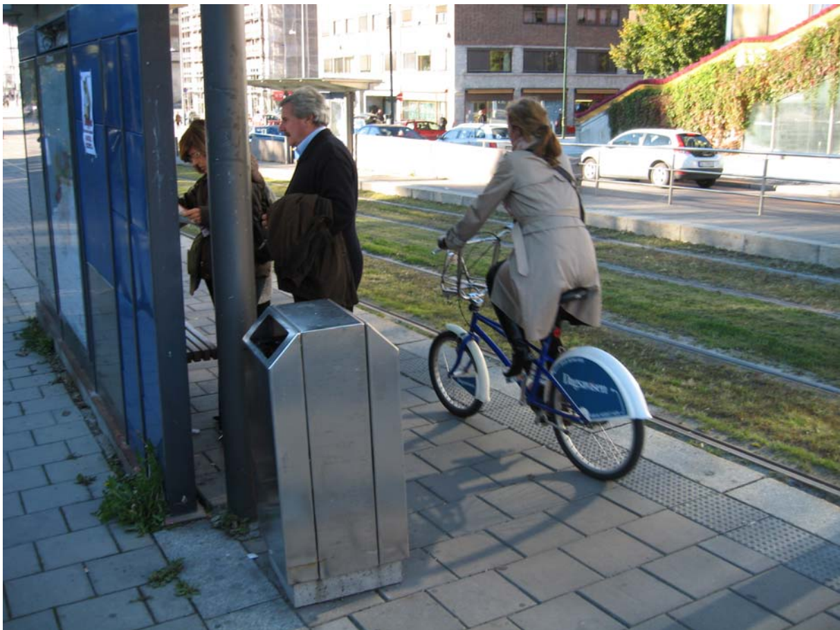
Foto 2 (over): Syklister ledes over holdeplassen, der kollektivreisende er opptatt av rutetabeller osv og ikke følger med i trafikkbildet. Kanten langs plattformen er ca 30 cm høy.
