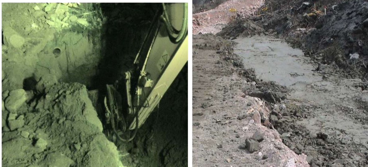
Figur 12. Bildene til venstre viser forgraving til om lag 7 m under eks. terreng på natt, og bildet til høyre ferdig tilbakefylt grøft.
