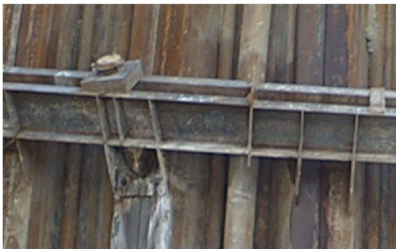
Figur 36. Staghode med påsveiset vinkelplate i underkant som tar opp skrålast fra staget med avvikende horisontalvinkel i forhold til pute.
