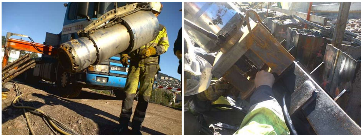
Figur 41. Bilder fra avlasting av stagene. Kilene må pirkes løs for å få avlastet stagene helt før stagene ble spent opp igjen til riktig forspenningslast.
