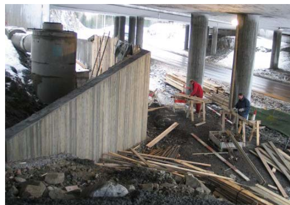
Figur 3: Betongen er avforskalt og ser fin ut
