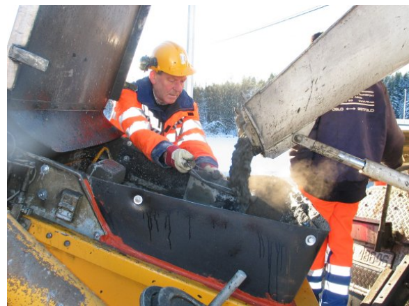
Figur 15: Per Sydsæther tar ut betongprøver
