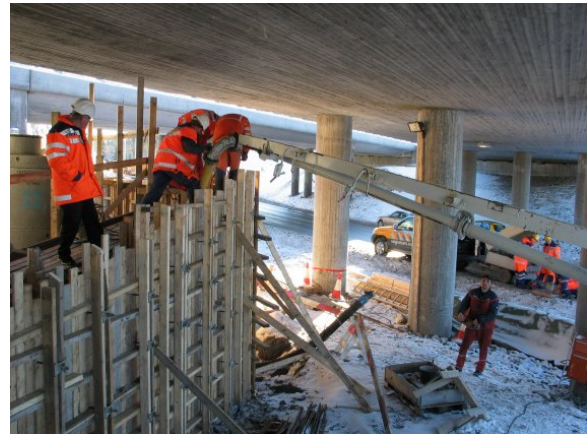
Figur 1: Betongen pumpes på plass i forma
