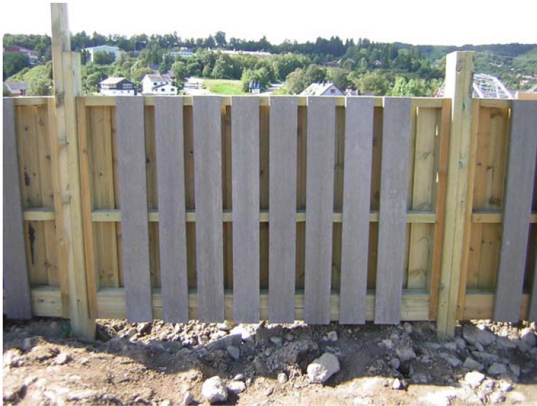
De første plankene av returplast er satt opp på E6 Melhus. På utsiden av skjermen brukes vanlig impregnert tre
