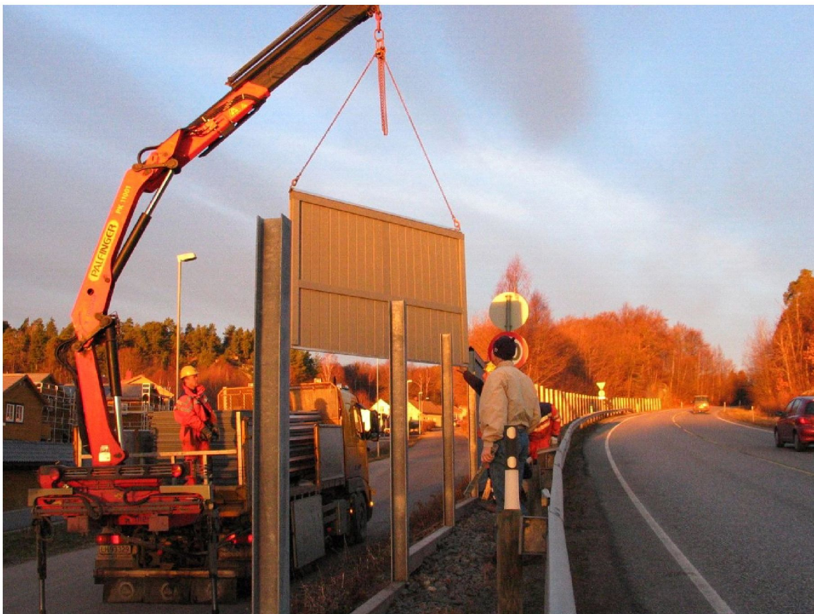
Montering av elementene går kjapt og problemfritt unna
