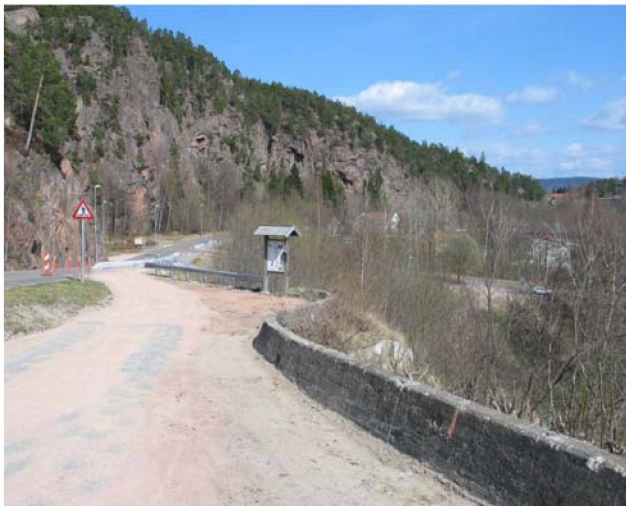
Sikring av rasteplass langs Rv 319 i Vestfold. Fra 50 cm til 90 cm på en arbeidsdag
