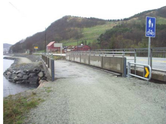
Fiskebekk bru ferdig montert
