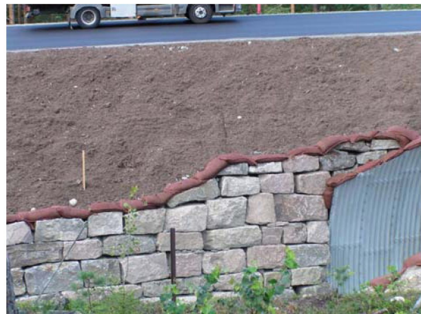
Ferdig utlagt kompost står godt. Sekkene på kanten er en type "torvtak"
