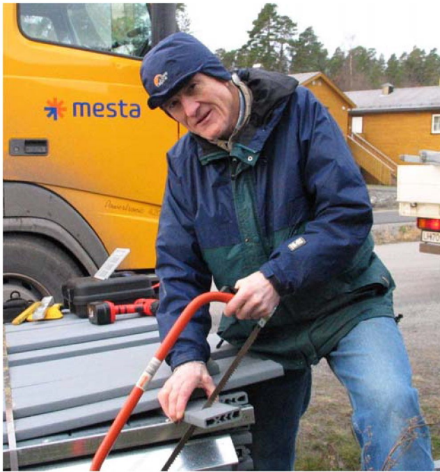
Jørgen B. Høiness fra Polyfiber demonstrerer kapping av dekkbord i riktig lengde
