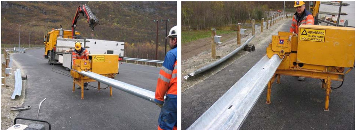
Mesta i sør Trøndelag bruker sin egenproduserte rekkverksretter i region nord Her brukes den ikke til oppretting, men for å tilpasse skinnene til kurvaturen på vegen
