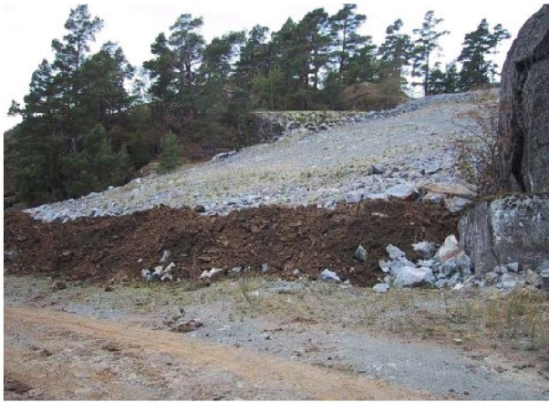
Tvedalen i Vestfold før og etter: Steintippen er påført et lag med mindre stein og så dekket med slam
