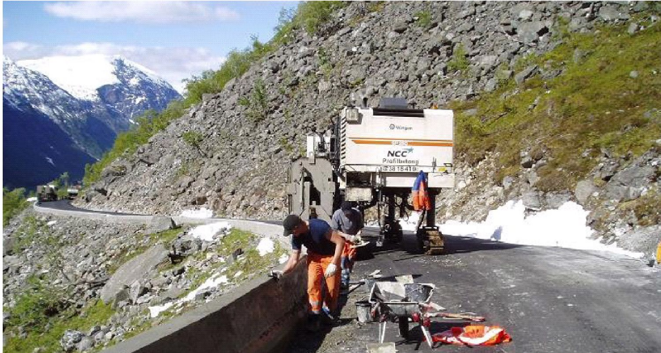
Fra støping av fender i Trollstigen
