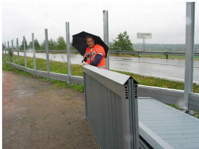
Byggeleder Pål Rødby inspiserer et av elementene
