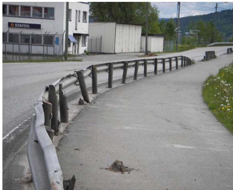
Godt brukt rekkverk på Rv 319 i Buskerud
