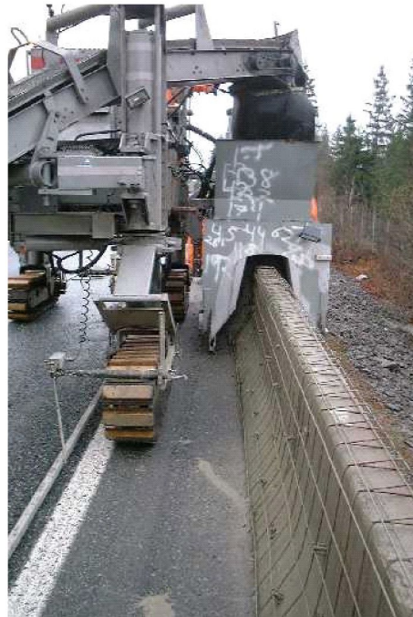
Ekstra armering er lagt på gammelt rekkverk før det støpes nytt
