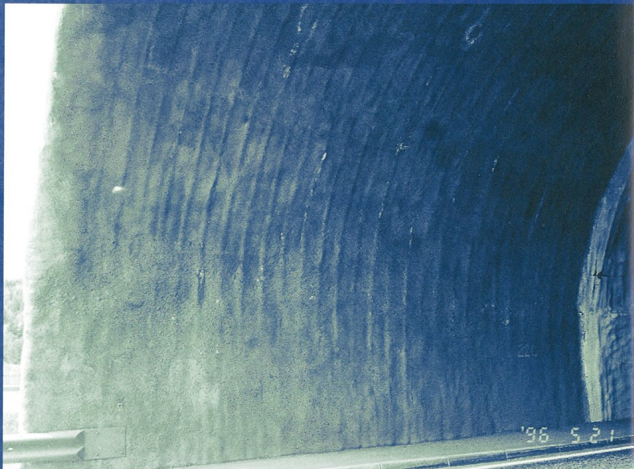
Portalen i Ringnestunnelen sett fra innsiden
