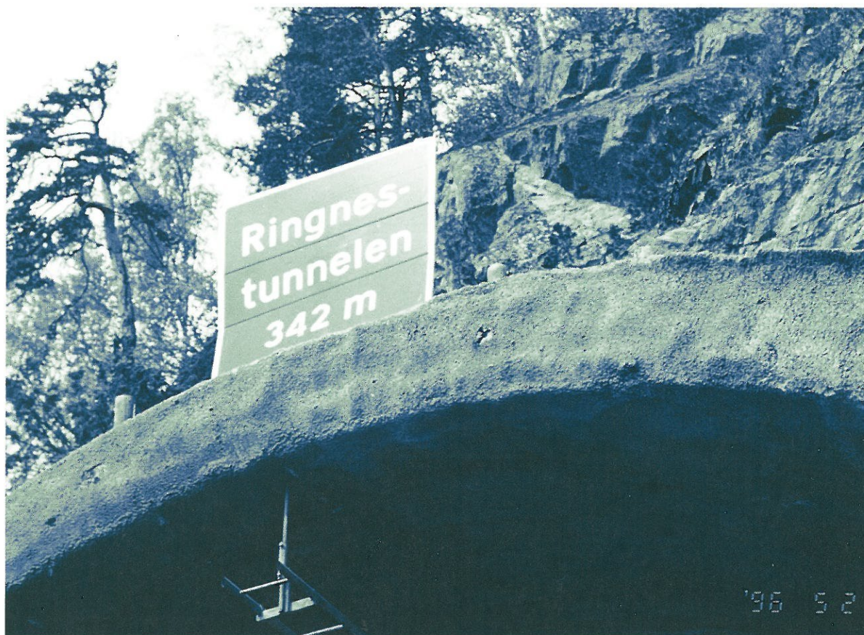
Sprøytebetongportalen i Ringnestunnelen
