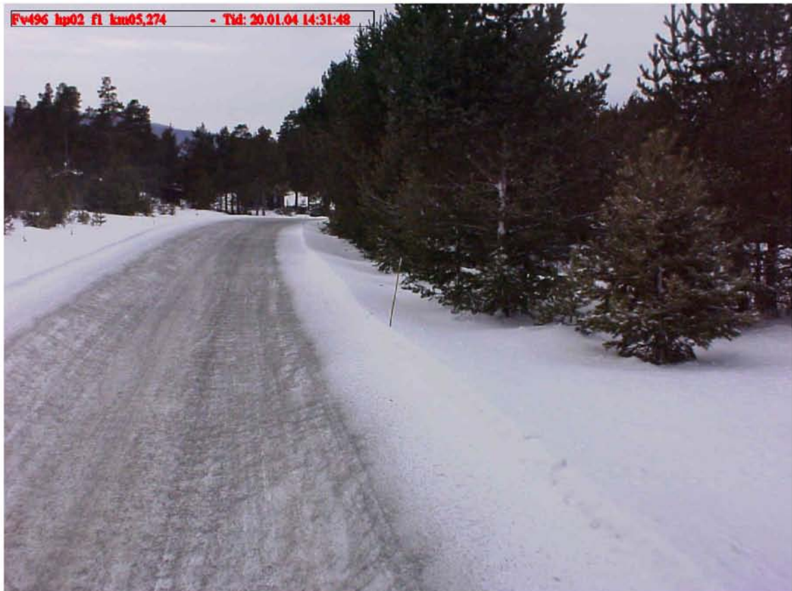
Figur 3.26: Fv 496, strekning 1, delfelt 2. Strødd med tørr sand 20. januar 2004
