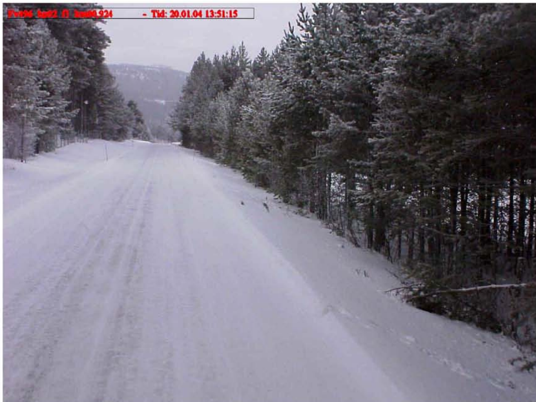
Figur 2.15: Situasjonen før strøing på Fv 496, strekning 2
