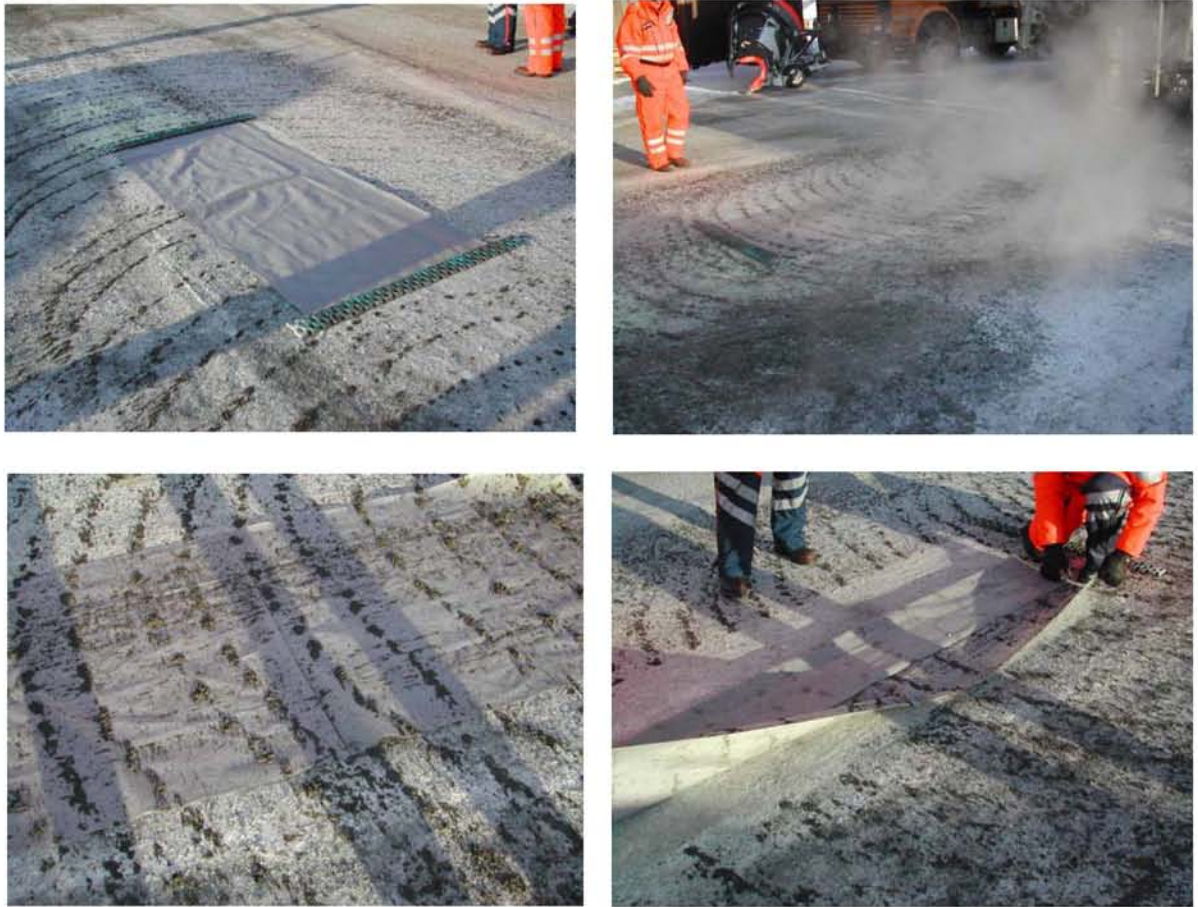
Figur 3.11: Materialprøvetaking ved bruk av fiberduk
