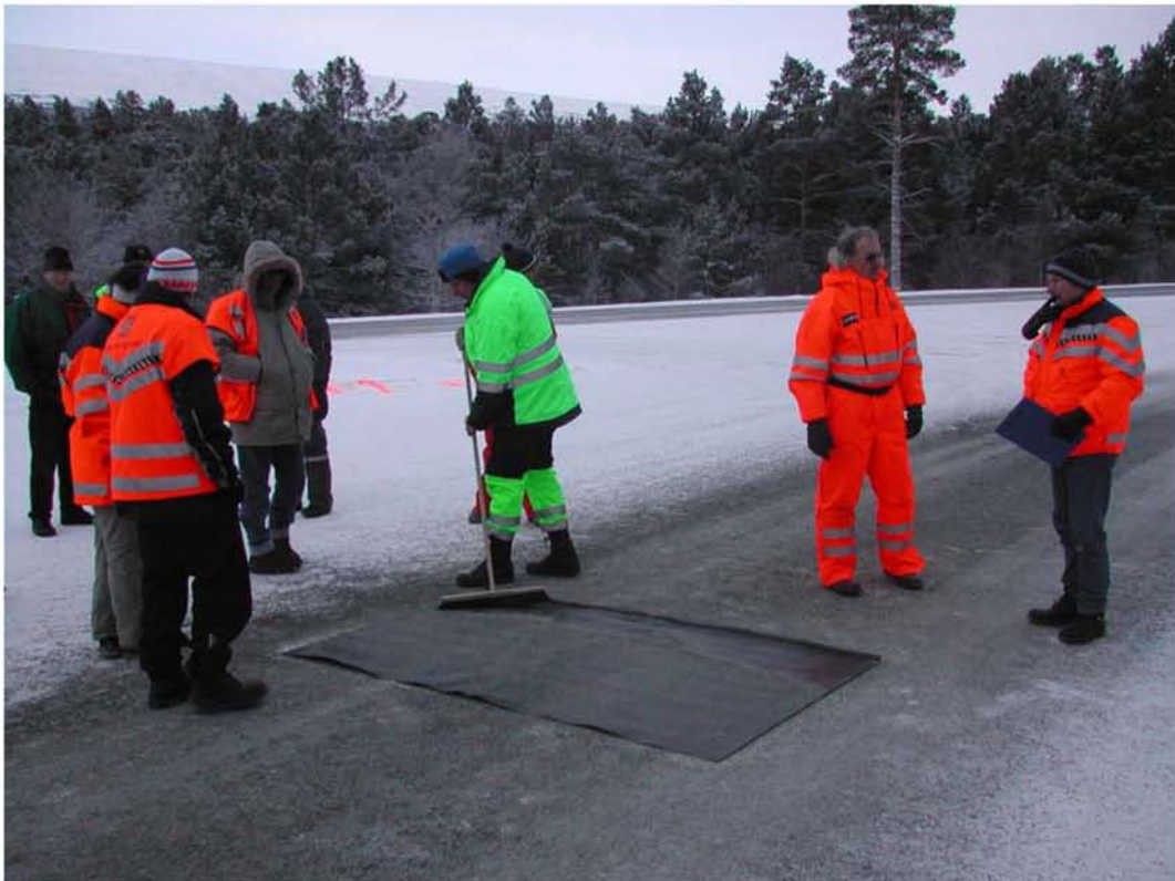
Figur 3.2: Kalibrering av strøpparater, oppsamling av grus
