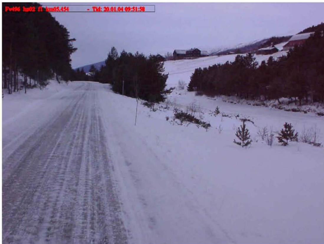
Figur 2.14: Situasjonen før strøing på Fv 496, strekning 1
