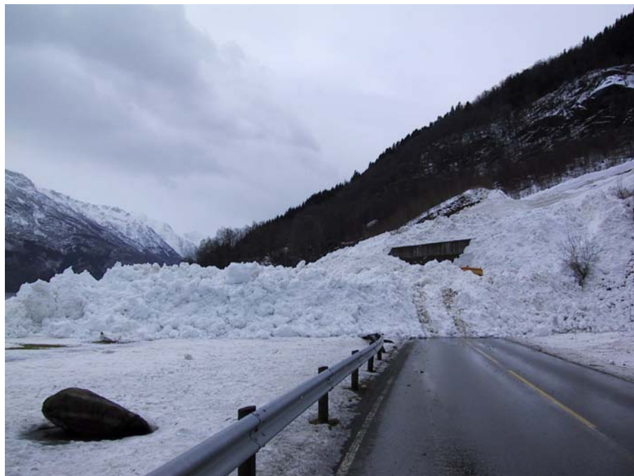
Bilde 3: Rv 550 Velure (Hordaland) viser overbygg som er bygd for kort.
