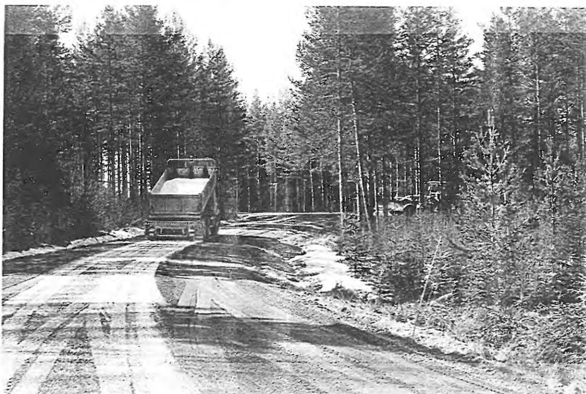
Figur 7 Utspredning av \text{CaCl}_2
