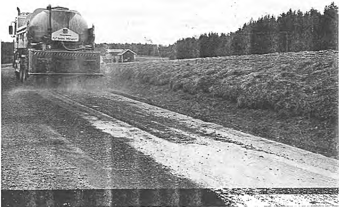
Figur 13 Utspredning av lignin (Dustex)
