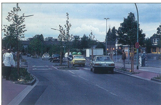
Figur 69: Innsnevring med midtdeler og midthump
