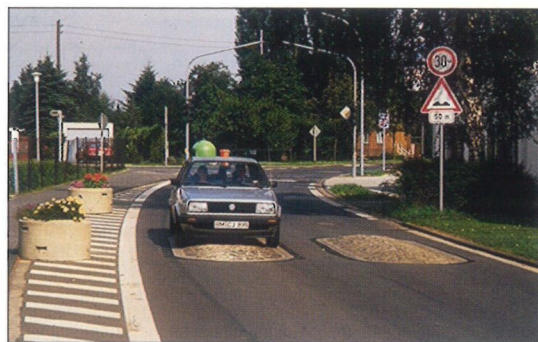
Figur 58: Langsgående vippehump med passasje for lastebiler og busser
