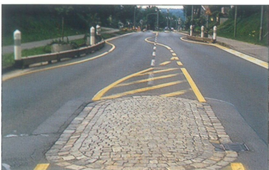
Figur 72: Sideforskyvning med midtdeler formet som hump
