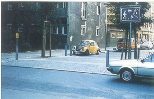
Figur 50: Innkjøring med platå og innsnevring
