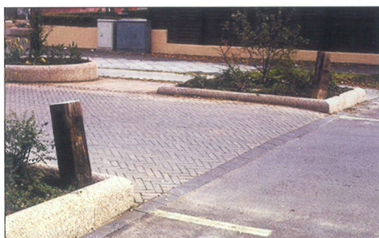
Figur 35: Platå med moderat rampestigning
