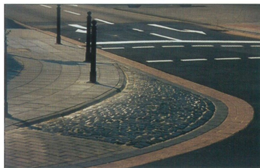
Figur 68: Innsnevring med utvidet kurvatur for lastebiler
