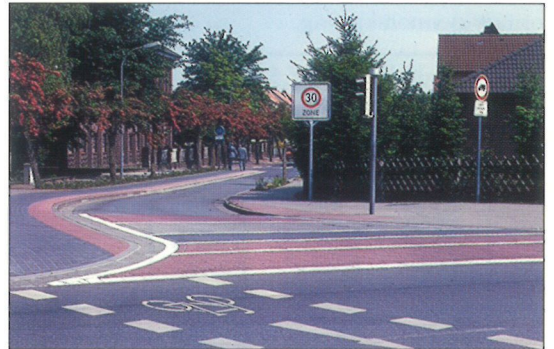
Figur 6: Utforming av innkjørsler til boligområder m.v. som oppmuntrer gjennomgangstrafikk til å kjøre utenom.
