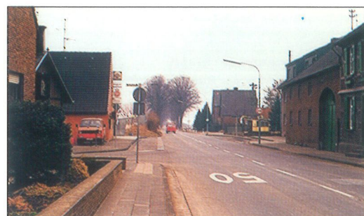
Figur 85: Konvensjonell gjennomfartsveg i tettsted
