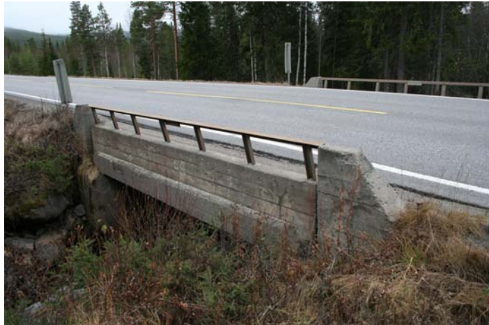
Figur 3. Påkjørt rekkverk Søndre Nor bru og Thingstadbekken bru nedfylt med 55 cm grus og asfalt.
