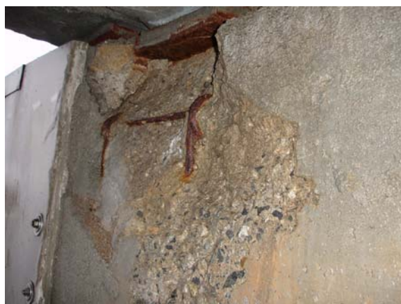
Figur 11 Virkelig plassering av armering
