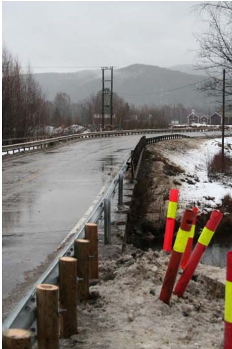
Figur 3. Påkjørt rekkverk Søndre Nor bru og Thingstadbekken bru nedfylt med 55 cm grus og asfalt.
