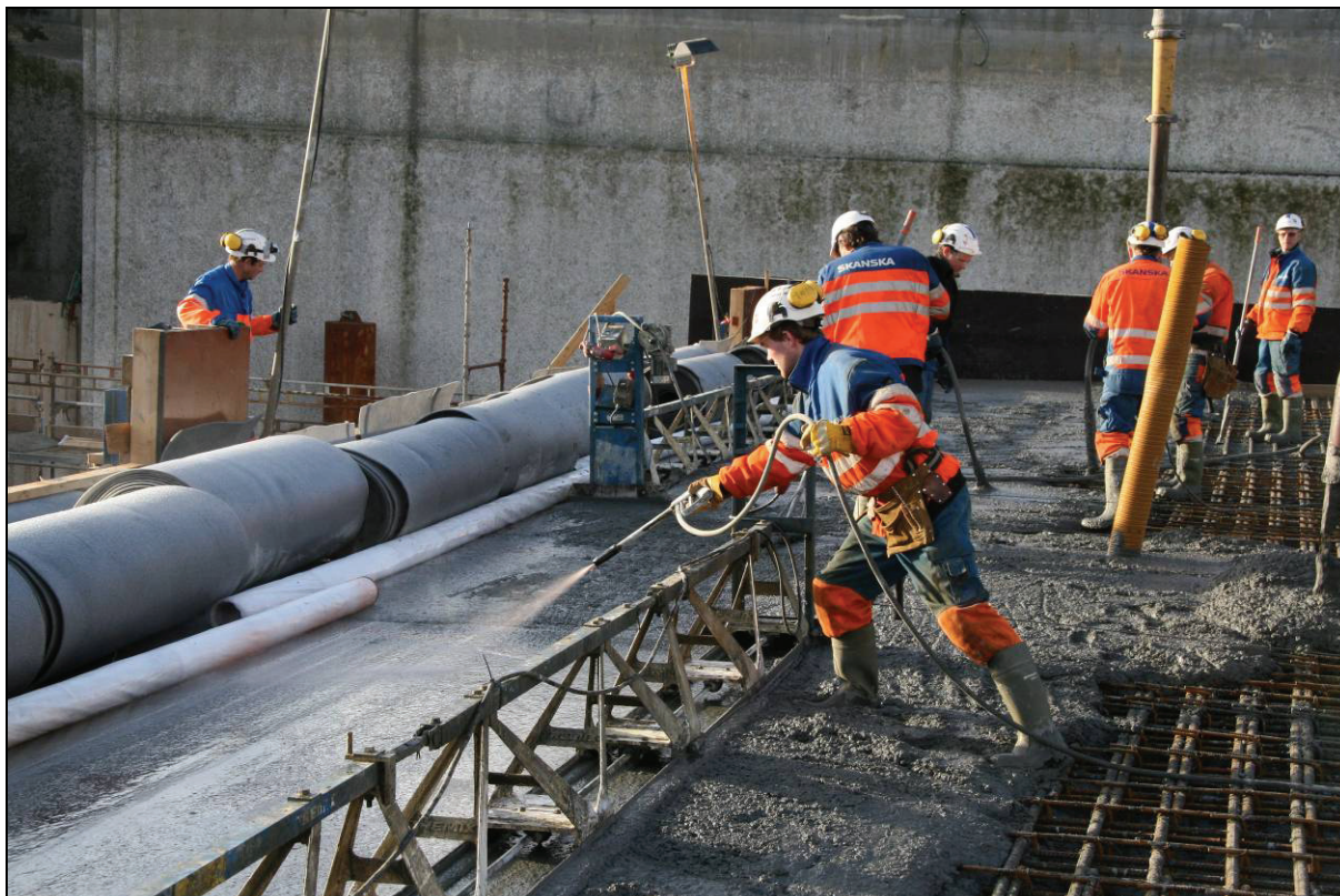
Figur 6 Herdetiltak ved støp av takplate; herdemembran, plastfolie og ethafoammatter
