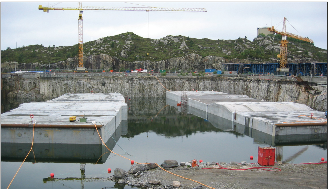
Figur 4. Fylling av dokka, 1.dokksetting
