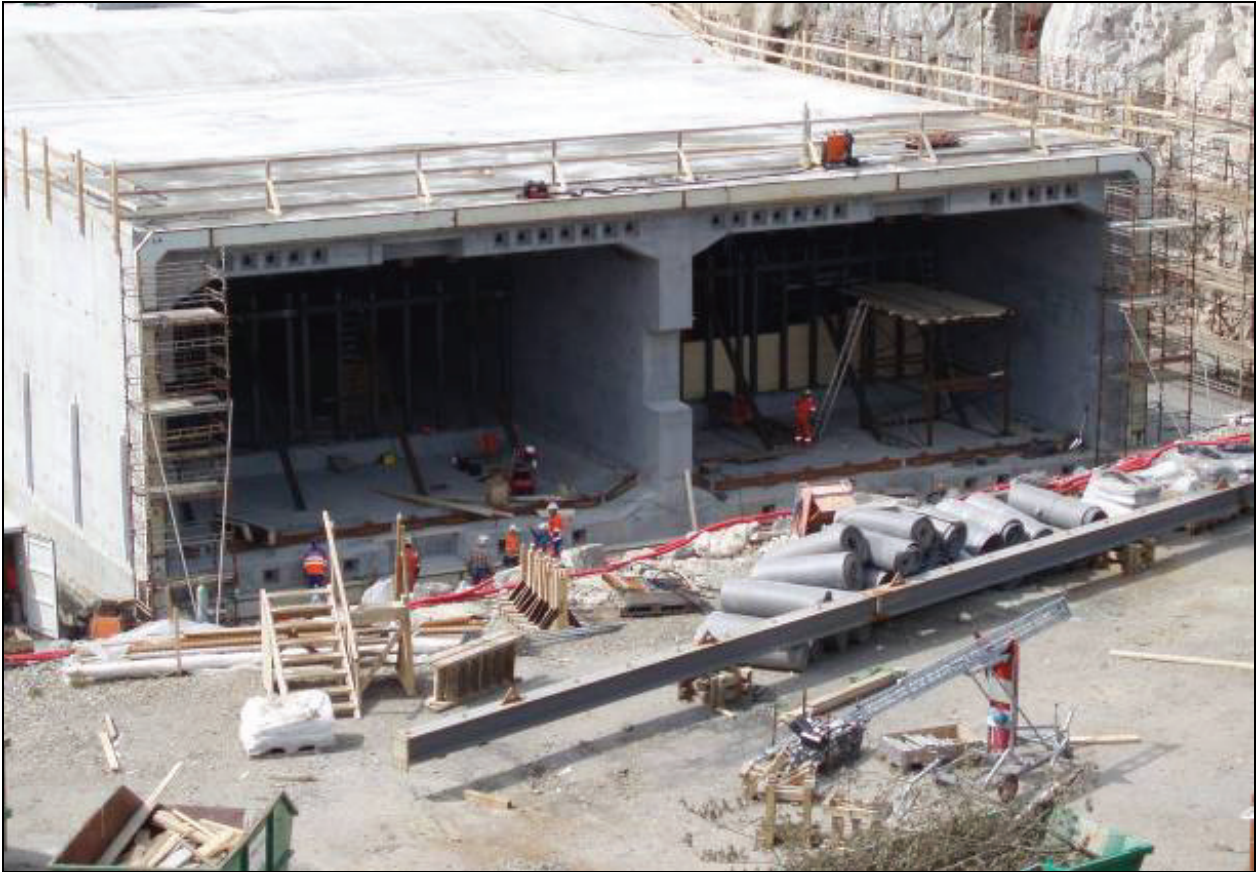
Figur 3. Tunnelement 3 før støp av endeskott
