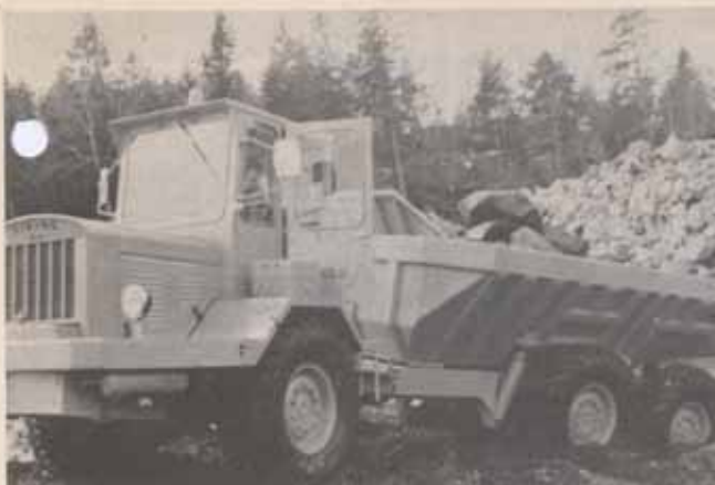
Spesialdumper, kan registreres for kjøring på veg. Norskbygget.
