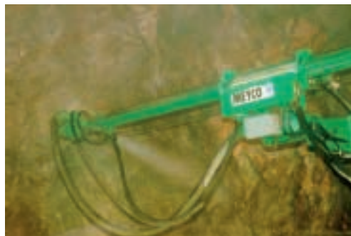
Figur 6 Betongsprøyting.
