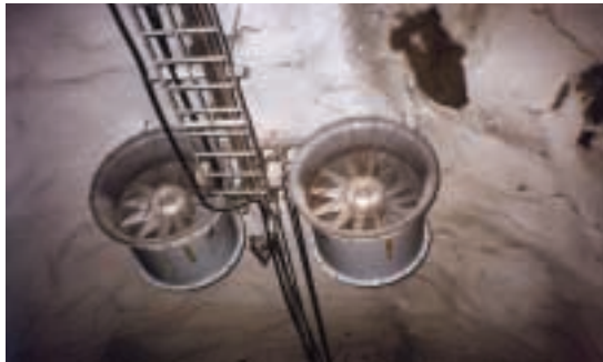
Figur 11 Ventilasjons- vifter.
