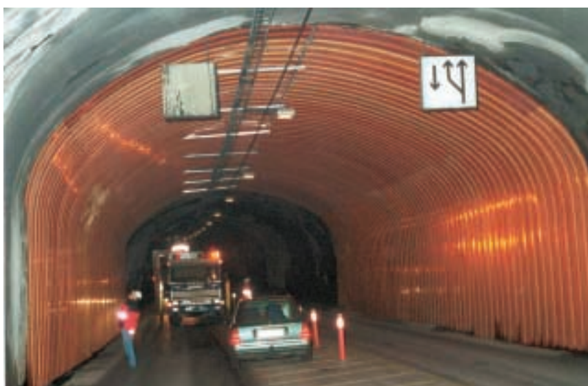
Figur 37 Prøvefelt i Valderøytunnelen.
