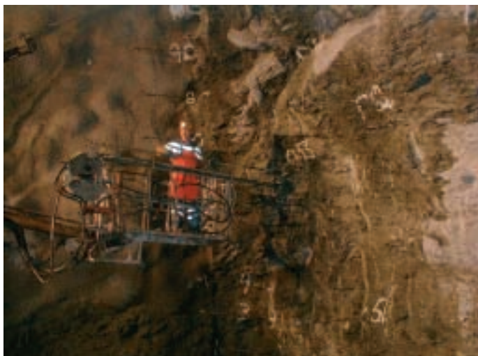
Figur 4 Injeksjon i Storhaug- tunnelen.
