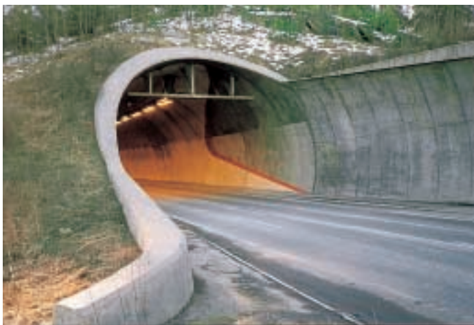
Figur 51 Utforming av tunnelportal.
