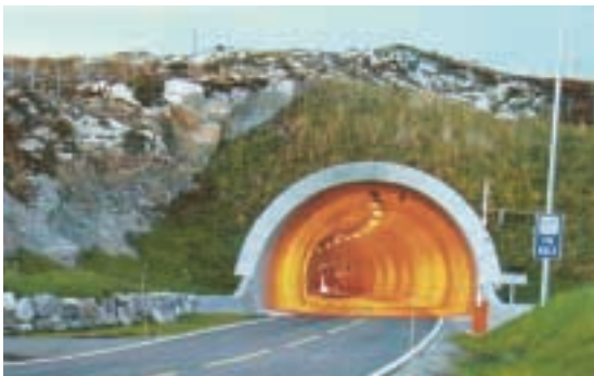
Figur 28 Åpen tunnel på Rennfast- forbindelsen.
