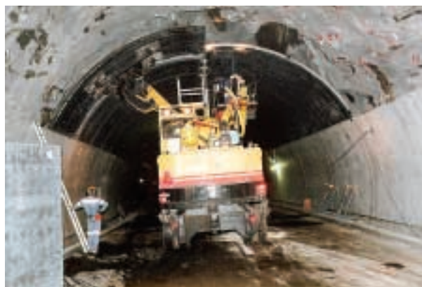
Figur 5 Montering Con Form-elementer i Bekkestua- tunnelen.
