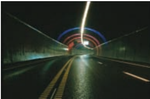
.Figur 49 Lyssetting i Oslofjord- tunnelen
