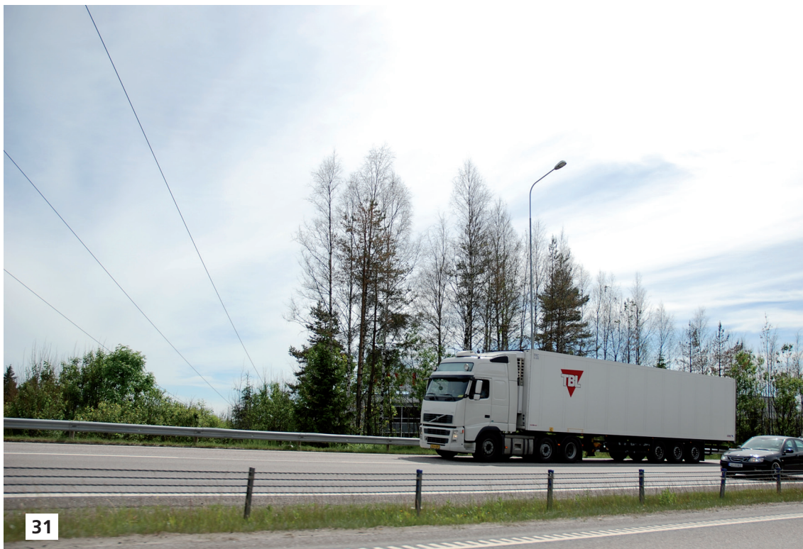
31. Tydelige skader langs E6 i Lørenskog. 100 km/t.
