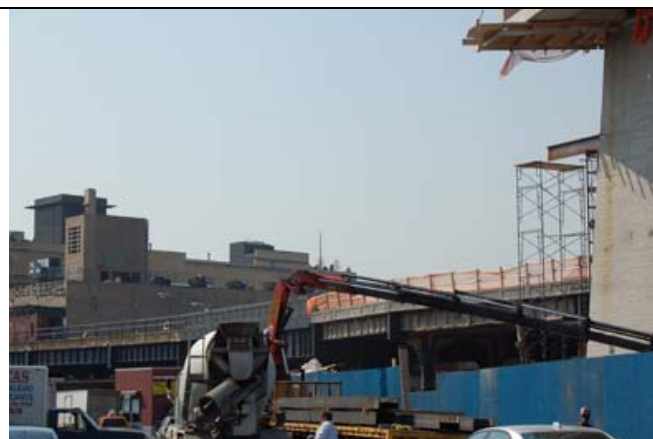
Arbeidet med restaurering av The High Line er i gang
