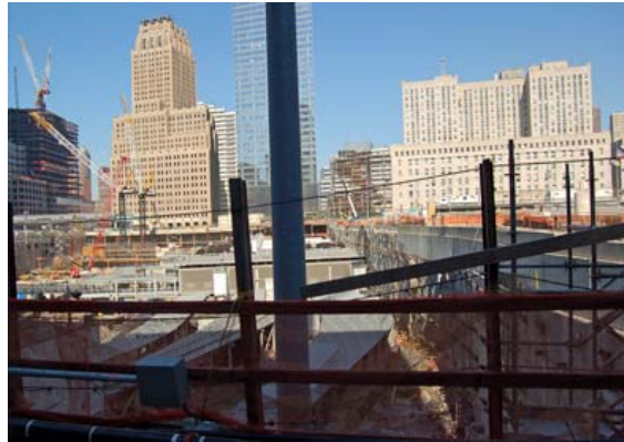
Ground Zero. Arbeidet med bygging av tub for Subway og jernbane pågår.
