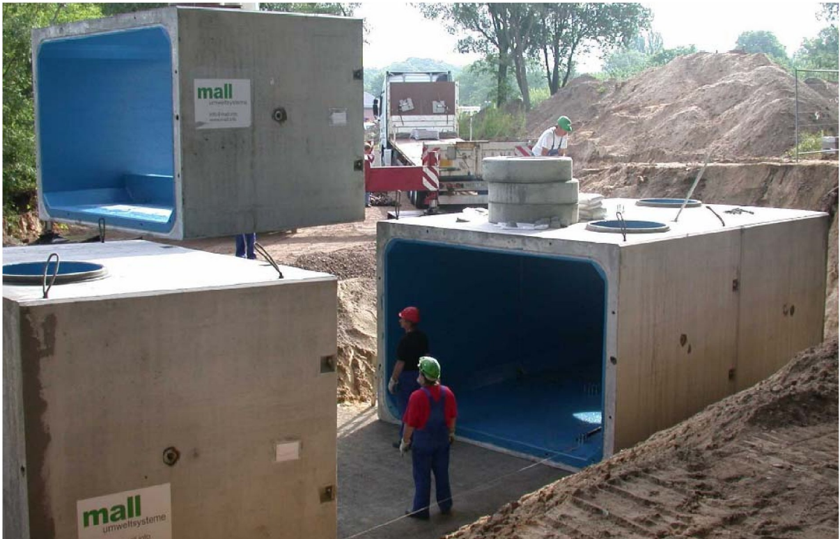
Figur 40. Viser prefabrikkert rensedbasseng i betongelementer under montering på motorveg A10 Rûderdorfer Brücke nær Berlin. Rensedbassenget behandler avrenning samlet opp i tette membranløsninger som beskytter grunnvannet langs vegstrekningen ( www.mall.info ).
