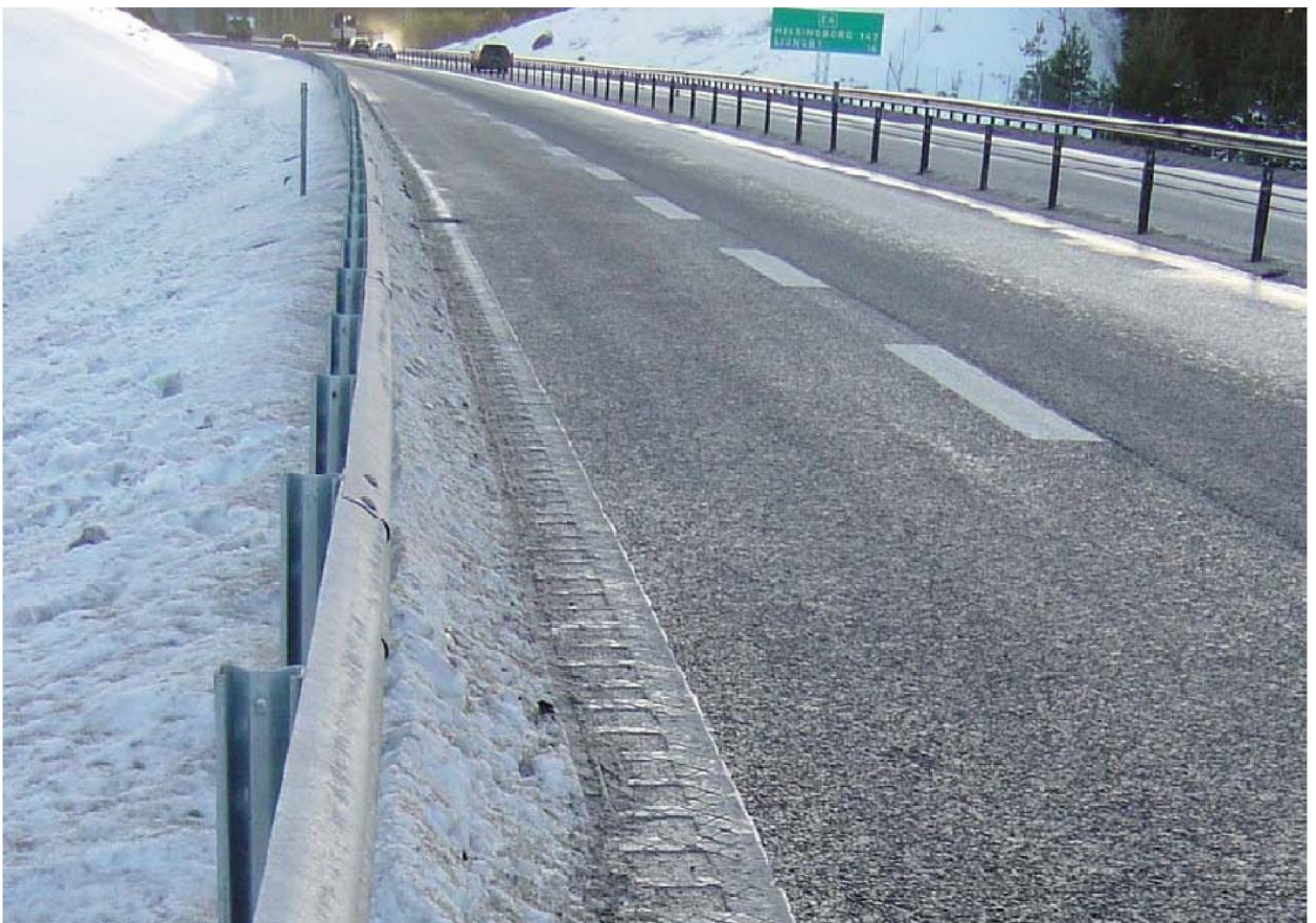
Figur 20. Viser oppsamling av avrenning fra E4 ved Bergaåsen i Sverige ved hjelp av kantstein og sluk. Øverste bilde: Sommersituasjon. Nederste bilde: Vintersituasjon. Fra Lundmark et al. (2007).
