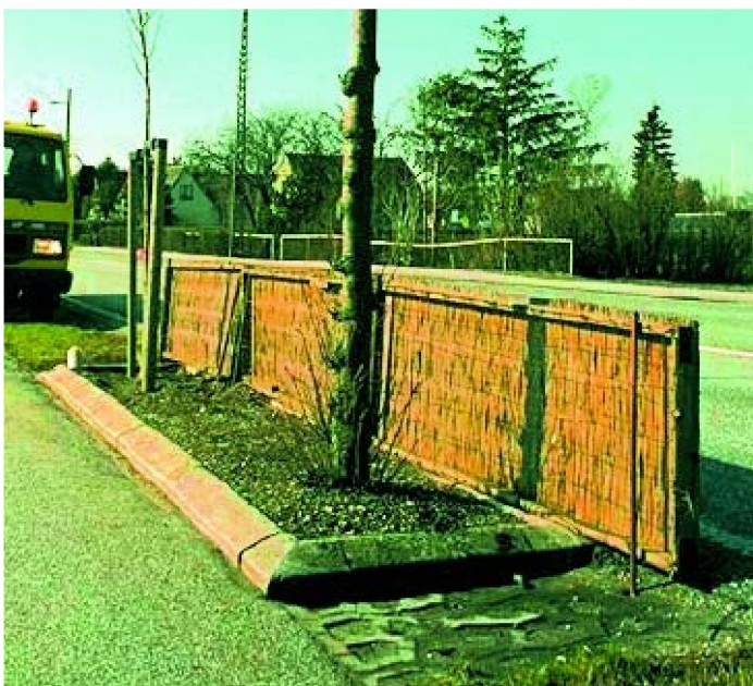
Figur 63. Et parallelt saltvern ga også gode resultater. Her kombinert med kantstein som hindrer saltholdig avrenning fra vegen å renne rett inn i rabatten (Vejdirektoratet 2001).
