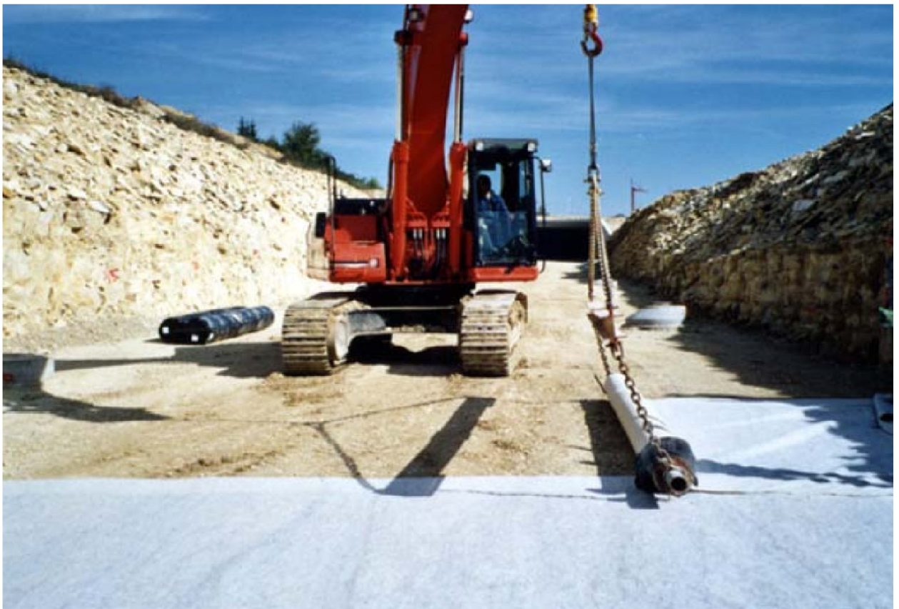
Figur 32. Viser utlegging av bentonittmatte under vegarbeid i Tyskland ( www.naue.com ).
