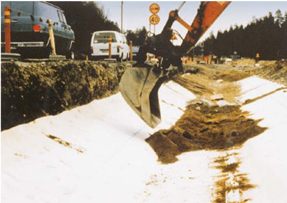
Figur 36. Legging av bentonittmembran i veggroft Finland.
