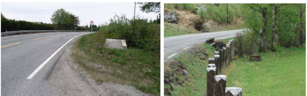
Figur 53. Noen brønner er plassert så tett inntil vegen at effektiv tiltak for beskyttelse er svært vanskelig (Fra Gundersen 2005).
