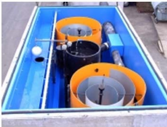
Figur 43. Viser prefabrikkerte virvelkammerløsninger for fjerning av partikkeltilknyttede forurensninger og oljekomponenter i avrenning fra veg i Tyskland ( www.awas-online.de ).
