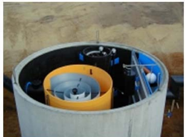
Figur 43. Viser prefabrikkerte virvelkammerløsninger for fjerning av partikkeltilknyttede forurensninger og oljekomponenter i avrenning fra veg i Tyskland ( www.awas-online.de ).
