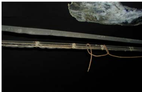
Kabelskader og deler av feltet i taket som hadde nedfall
