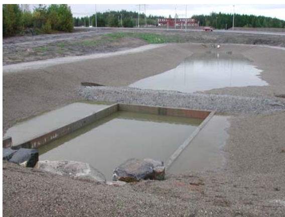
Figur 10: Rensedam for behandling av overvann E6 ved Taraldrud i Ski kommune med helstøpt sedimentasjonskammer og vanddyp i hovedbasseng 2,5 m (Foto: Roger Roseth).
