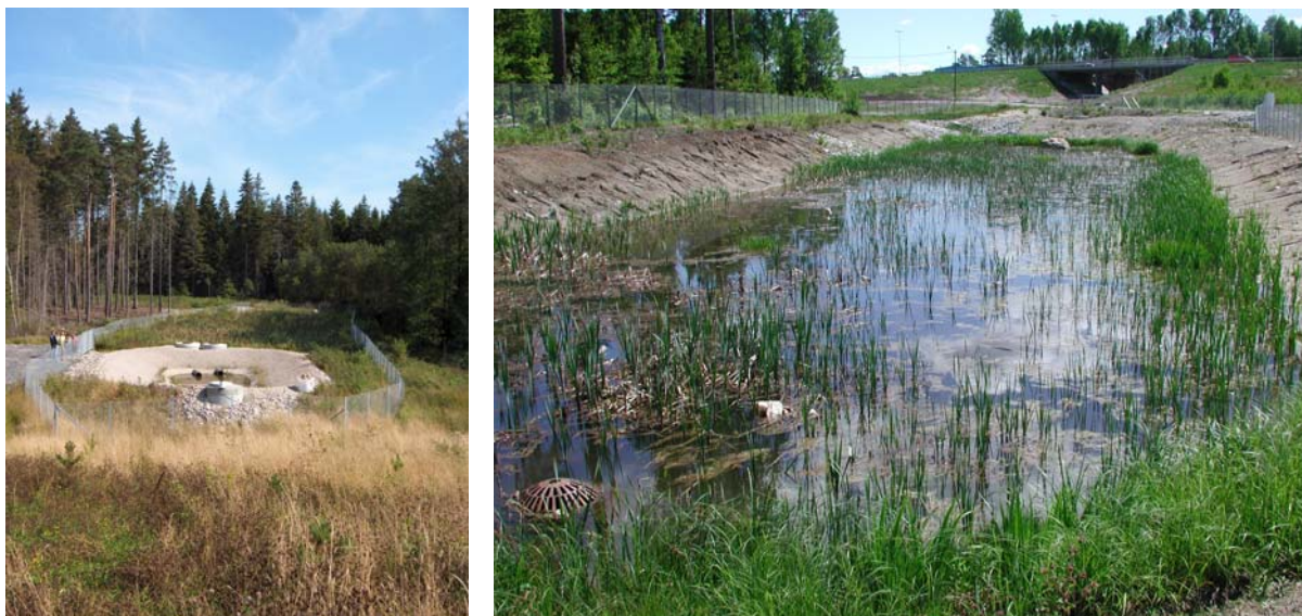
Figur 12: Rensedammer ved E6 i Råde som består av et eget sedimentasjonsbasseng med hard bunn etterfulgt av et grunt våtmarksfilter (0,5 m) med overløp til bekk (Foto: Roger Roseth).
