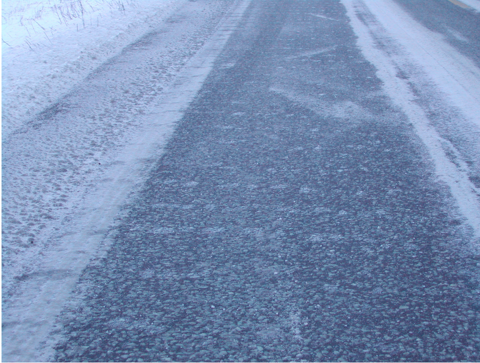
Figur 3.1: Strøbilde ved bruk av varmt vann som befuktingsvæske
