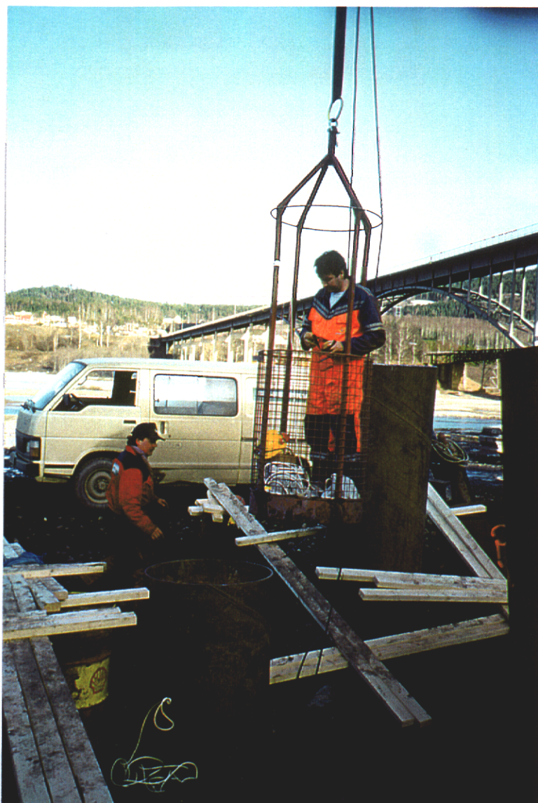
Fig. 13 Stålkurv som ble brukt ved montering av strekkklapper
