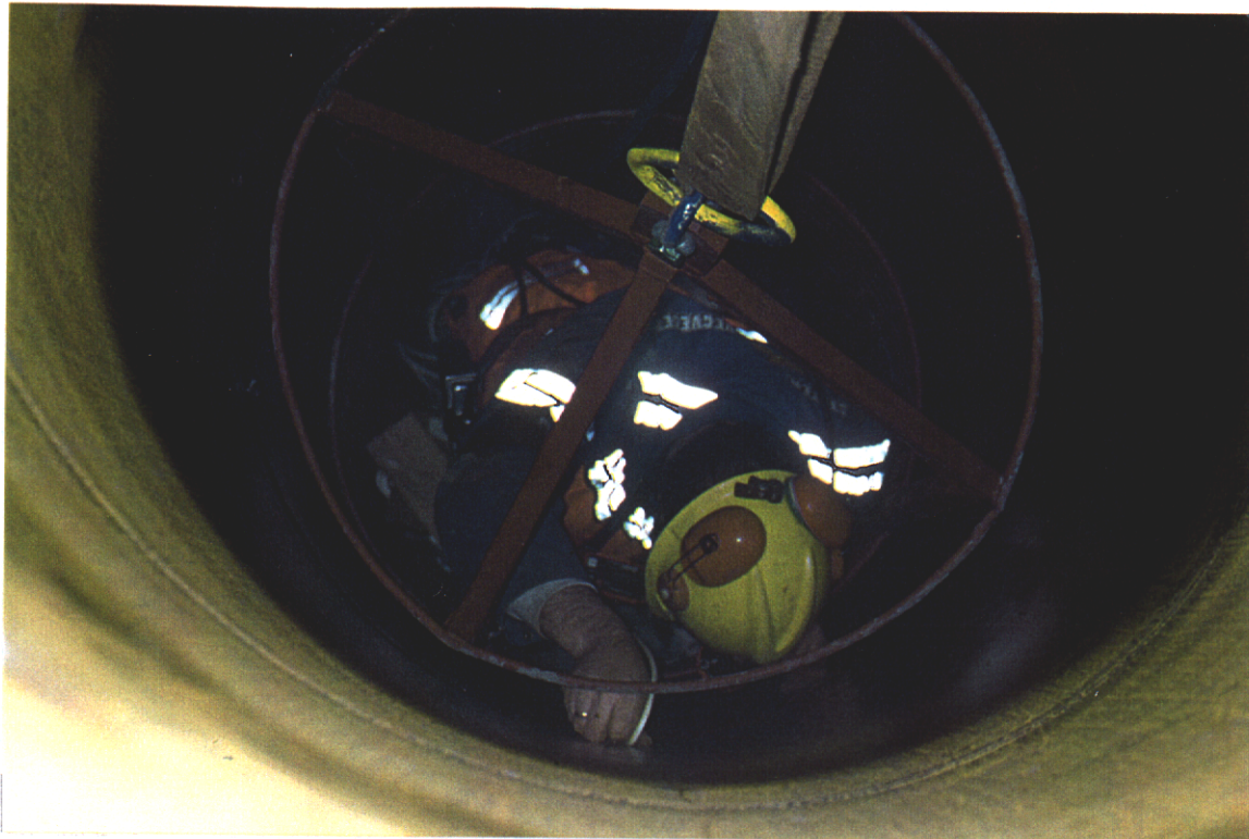
Figur 14 Montering av strekkklapper i prøvepelen
