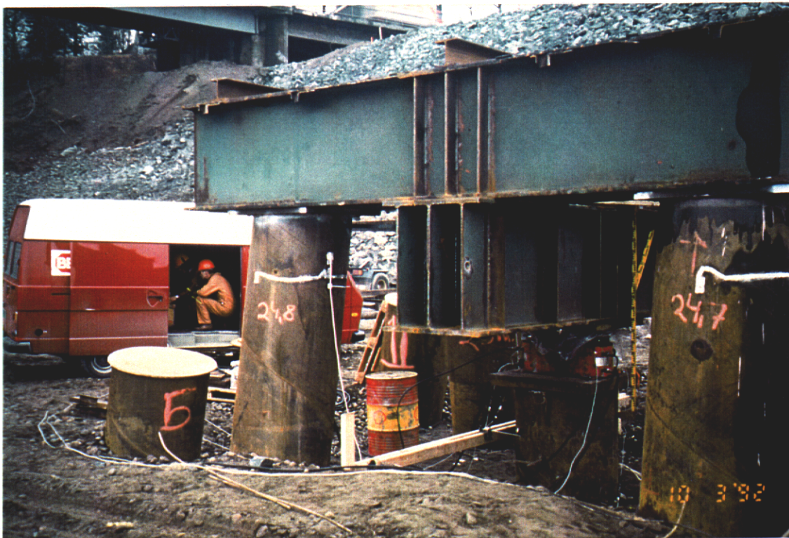
Figur 5 Lastceller ferdig installert for prøvebelastning
