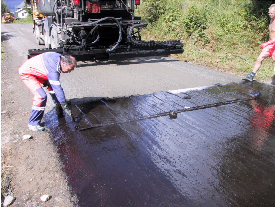
Figur 7. Kontroll av bindemiddelforbruk
