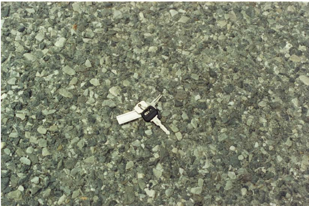
Figur 10. Fv 358-01. Overflatestruktur to måneder etter legging (10.10.02).
