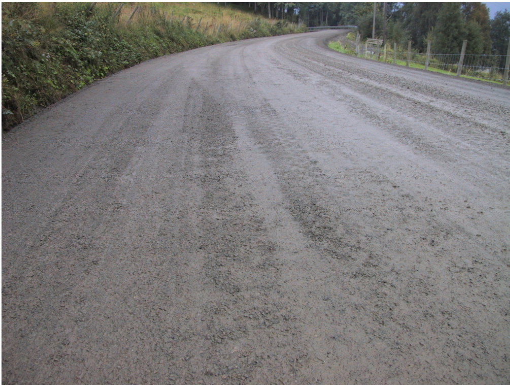
Figur 1. Fv 358-01. Ferdig avrettet grusunderlag
