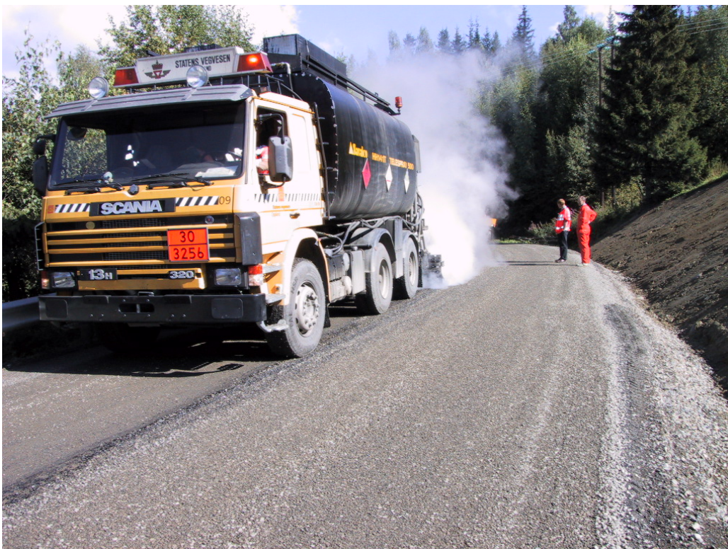
Figur 2. Utsprøyting av bindemiddel
