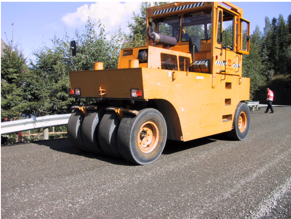
Figur 4. Valsing med gummihjulsvals
