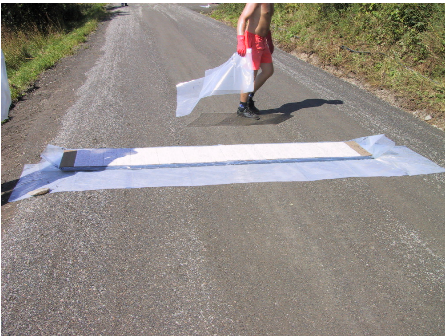
Figur 6. Utlegging av trefiberplater til kontroll av bindemiddelforbruk
