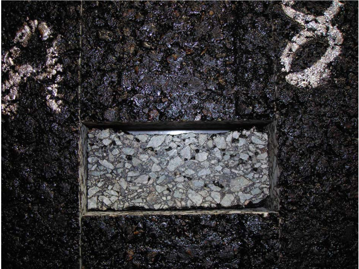
Figur 9 Ska 8 etter testing i wheel-track
