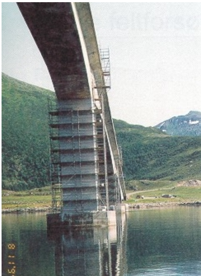
Foto: 5.6.3: Stållillas på søyle 4.
