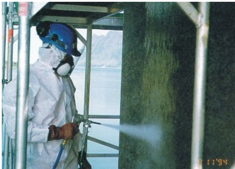
Foto 5.2.2: Påføring av hydrofobering.
