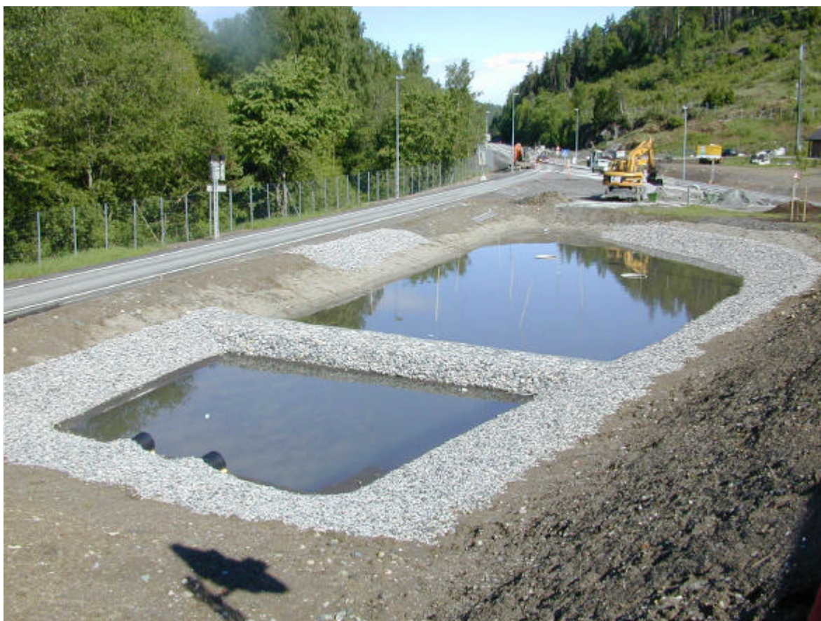
Figur 6. Overvannsbasseng med sedimentasjonsdam og hovedbasseng for behandling av avrenning fra Nordby-, Smihagen- og Vassum-tunnelen og noe veg. Foto: Roger Roseth.
