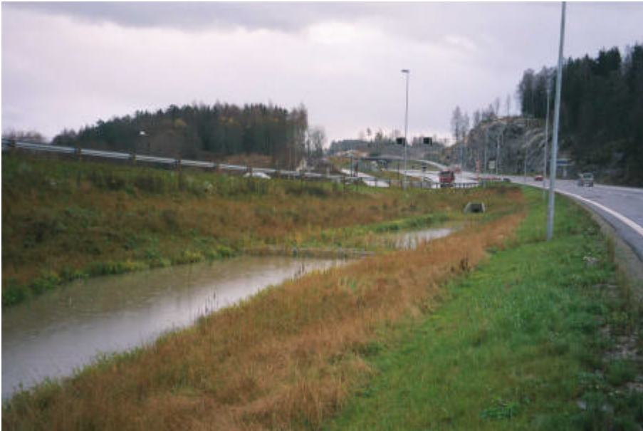
Figur 4. Fangdammen ved Årungstubukta består av et sedimentasjonskammer og to våtmarksfiltre adskilt av permeable demninger. Foto: Roger Roseth.
