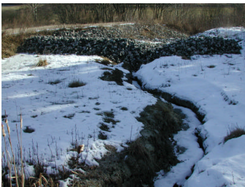
Figur 3. Dambrudd i utløpsdam for våtmarksfilteret ved Fagernes. Foto: Roger Roseth.
