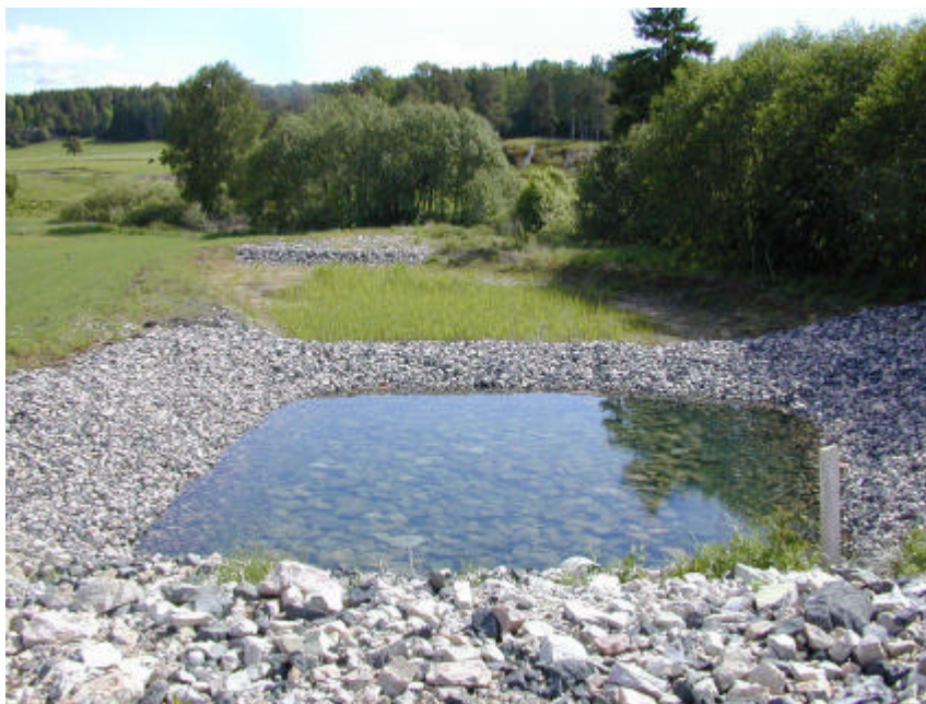
Figur 2. Fangdammen ved Fagernes består av et sedimentasjonsbasseng og et våtmarksfilter og behandler avrenning fra 37 daa vegflate. Foto: Roger Roseth.
