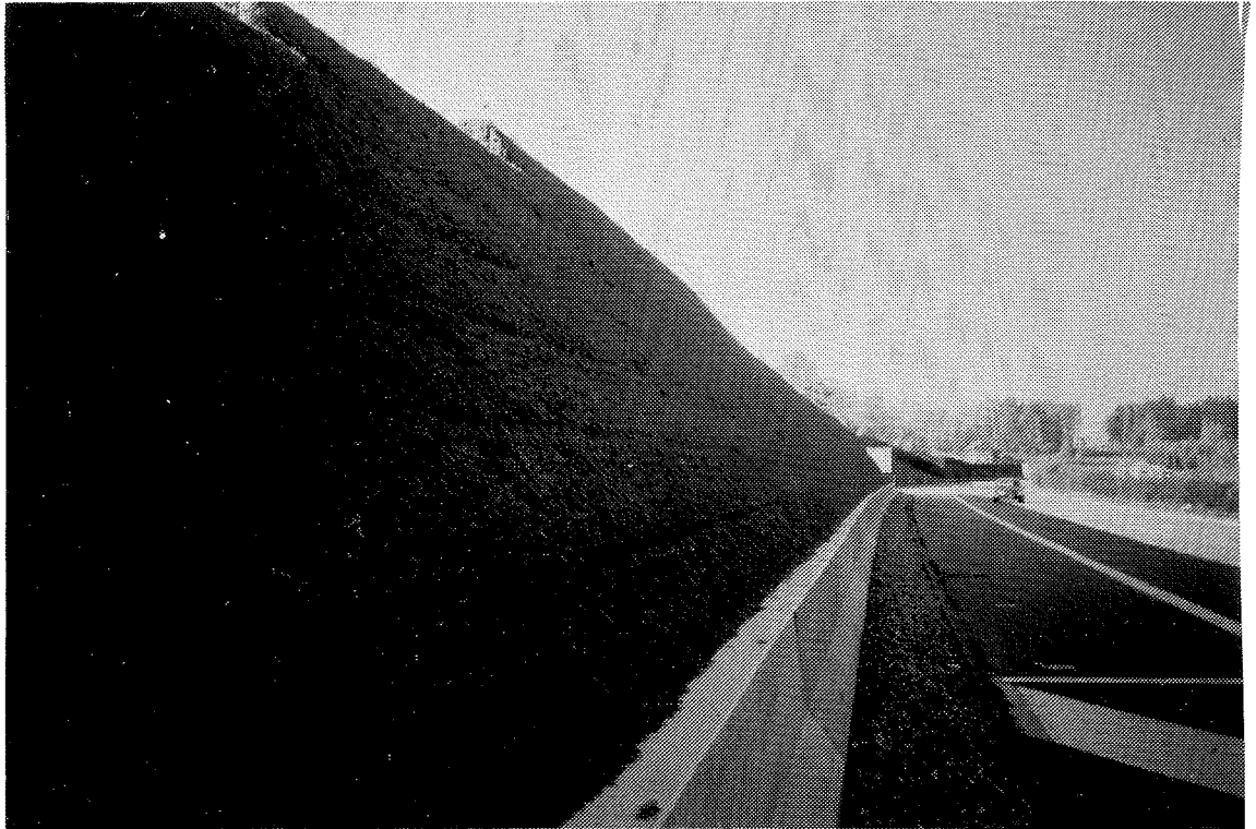
Fig. 16. Støyvoll med vegetasjon etter Textomursystemet
