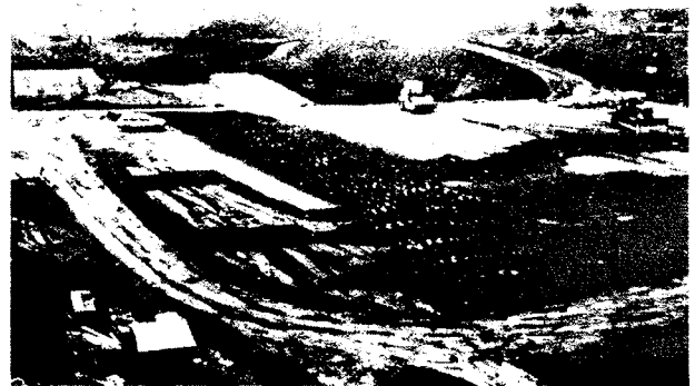
Fig. 2 : Disposition du Pneusol au-dessus d'une voûte
