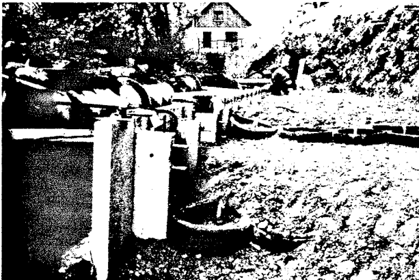
Fig. 1 : Mur Pneusol avec parement en béton
