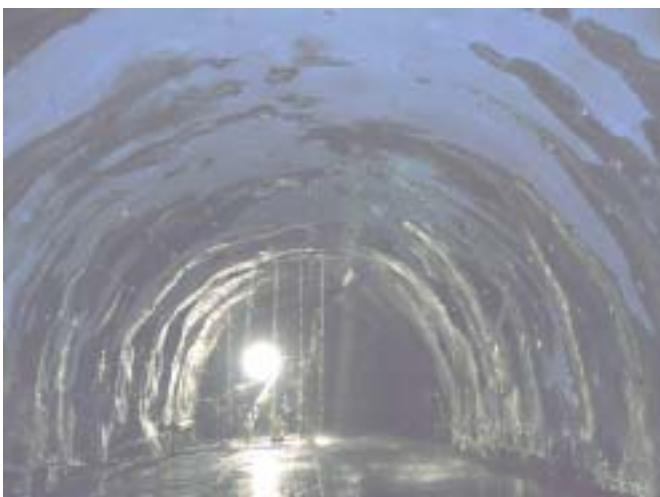
Figur 4.4: Lekkasjer i tunnel og kostbar etterinjeksjon unngås med et godt planlagt injeksjonsopplegg (foto: H. Hamar).
