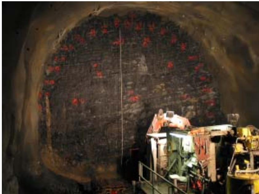
Figur 4.3: Fra Tanumtunnelen (Jong–Asker). Bildet viser en injeksjonsskjerm med hull i såle, rundt profilet og i stuffen. Etablert praksis har vist at det er fordelaktig å starte en injeksjonsrunde med å injisere sålehullene først. Deretter injiseres vegg hullene sammen med stuff hullene suksessivt og til slutt hullene i hengen (foto: Alf Kveen).
