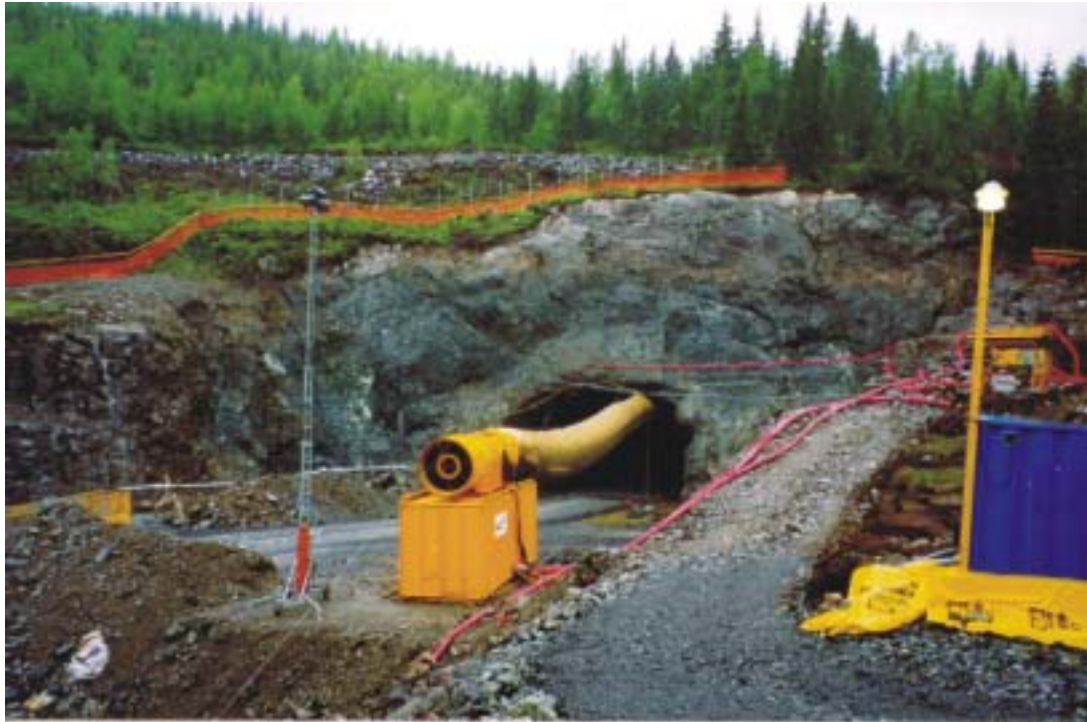
Figur 1.1: Lunnertunnelen, østre påhugg (foto: Mona Lindstrøm).
