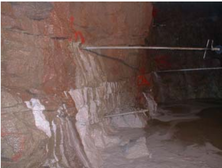
Figur 4.3: Injeksjon i syenitt, Hagantunnelen (foto: Alf Kveen).
