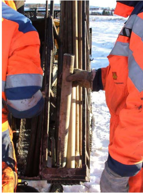
Fig. 16 Oppbevaring av full prøvesylinder i stanglageret mens motoren er i gang.
