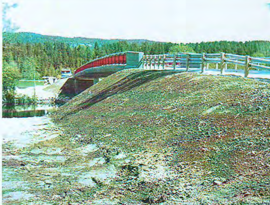
Bilde 19 : Som et estetisk tiltak er brurekkverket pulverlakkert i rød farge.
