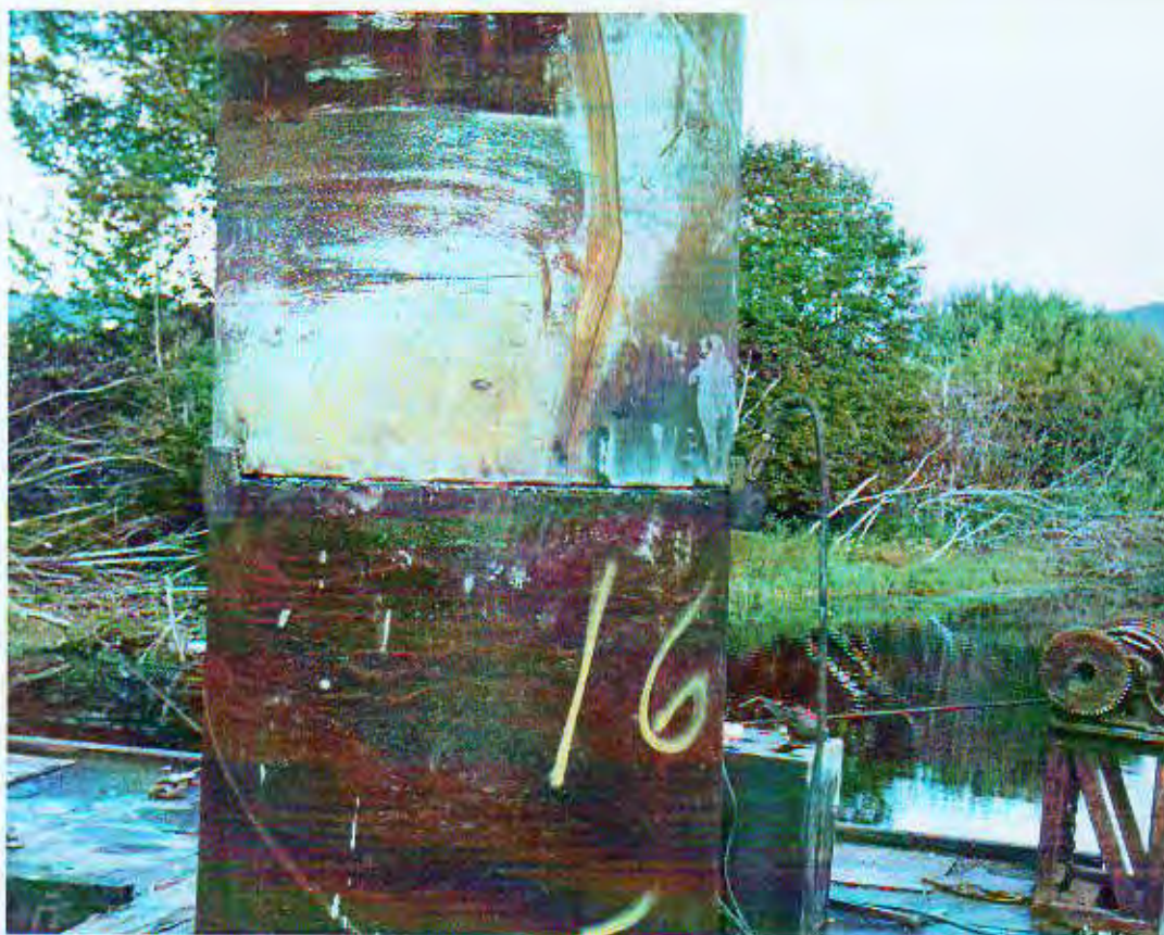
Bilde 23 : Sveiseskjøt mellom 2 stålrørslengder i elva.
