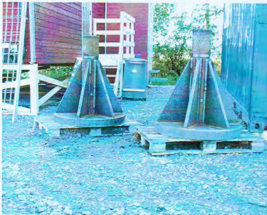
Bilde 24 : Pelespissene som ble sveist på stålrørspelen i henholdsvis akse 2 og 3.
