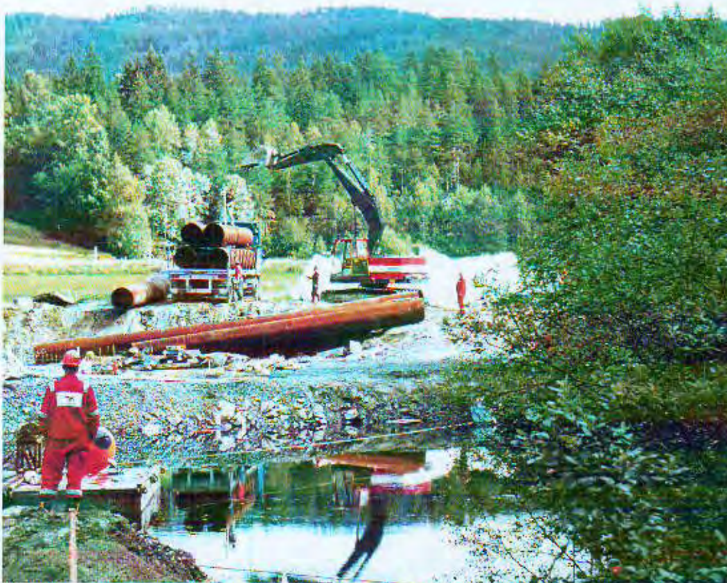
Bilde 21 : Ankommet parti med stålrørspeler som ble brukt under ramming i elva.
