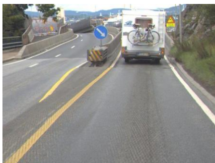
Fig. 24 Oppstart midtrekkverk
