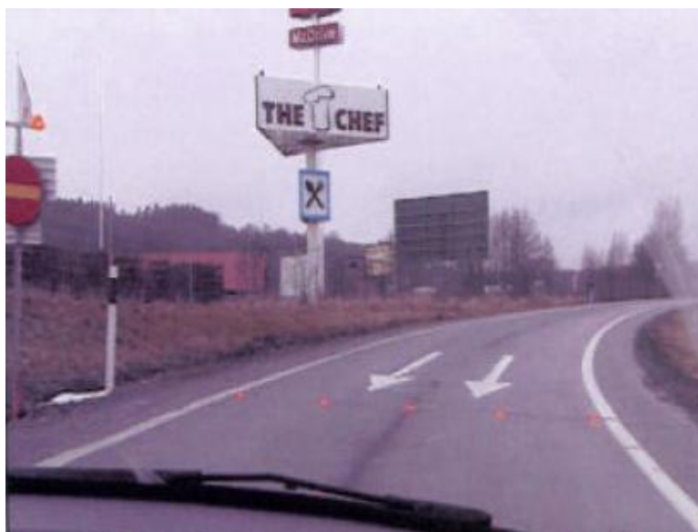
Fig. 7: Rampe i Varberg med innkjøring forbudt-skilt med blinkende signaler samt LED-lys og oppmerkede piler i vegbanen (Kilde: Vägverket)
