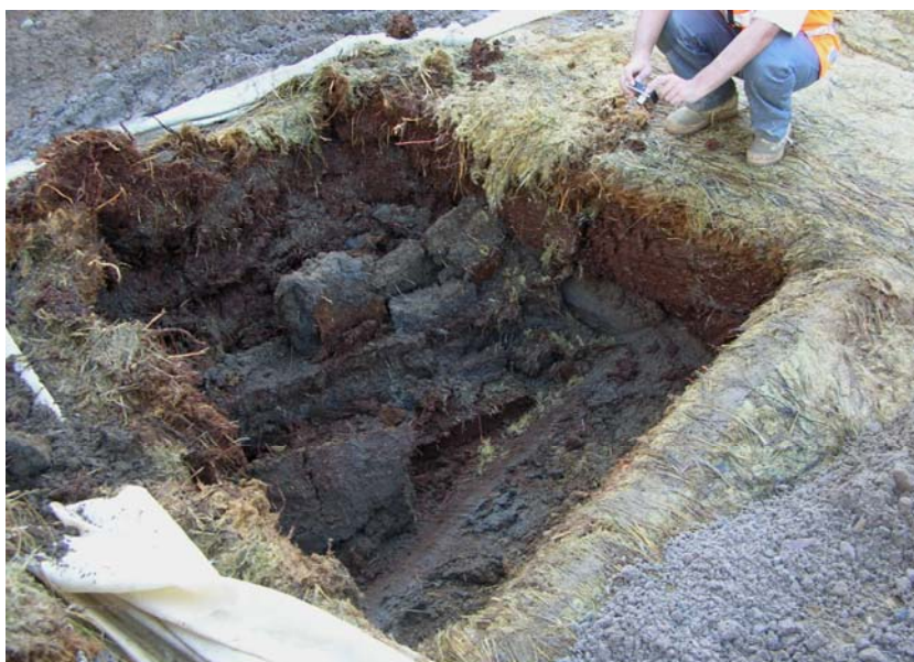
Figur 3: Prøvegraving under anleggsveg
