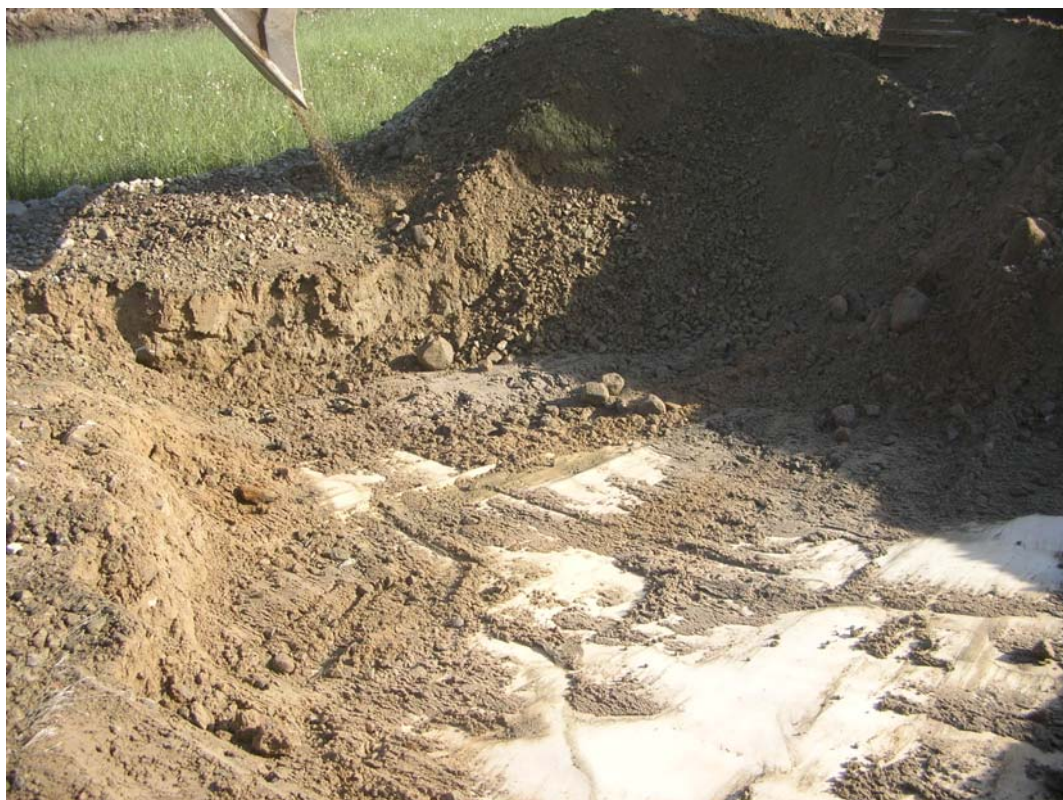
Figur 10: Frigraving av armeringsduk
