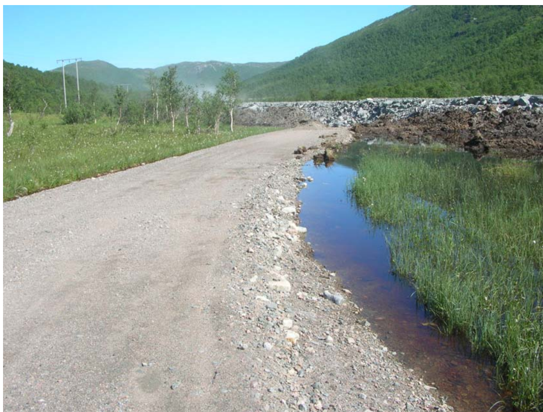
Figur 5: Teststrekning av anleggsvegen
