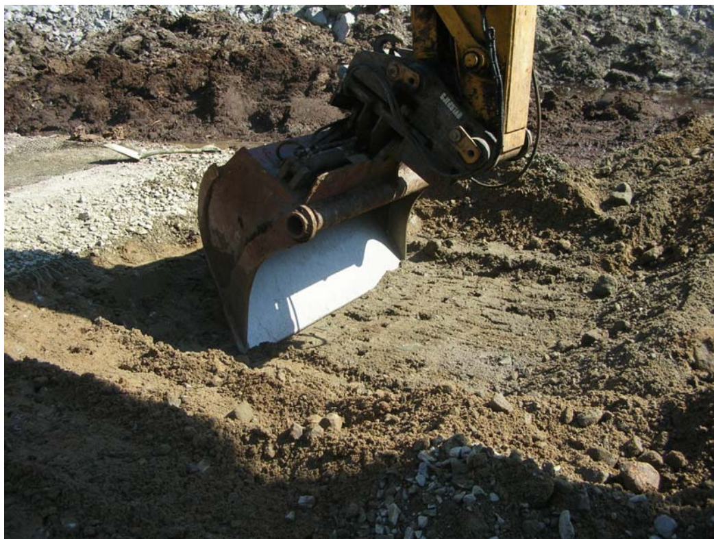
Figur 8: Bortgraving og frigraving av armeringsnett
