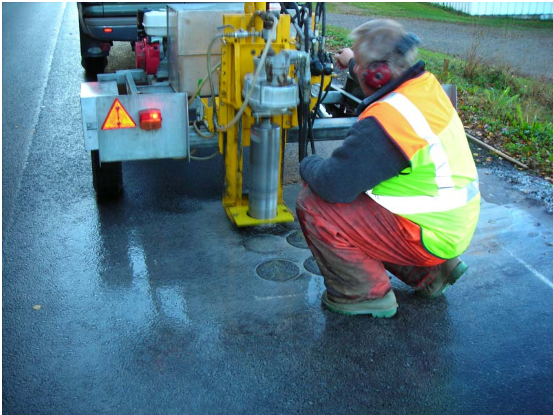
Figur 1 Boring av asfaltprøver i felt
