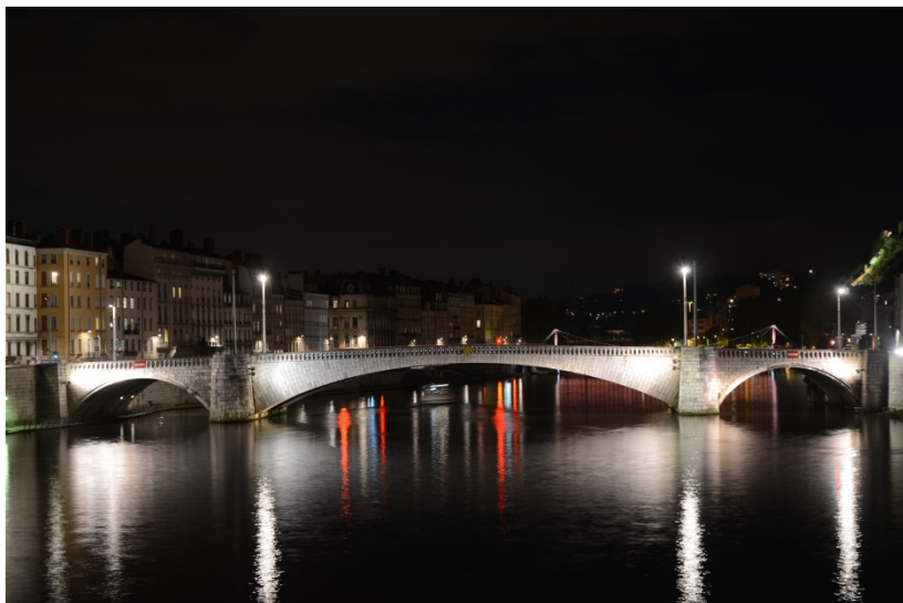
Gammel bru med enkel fasadebelysning
