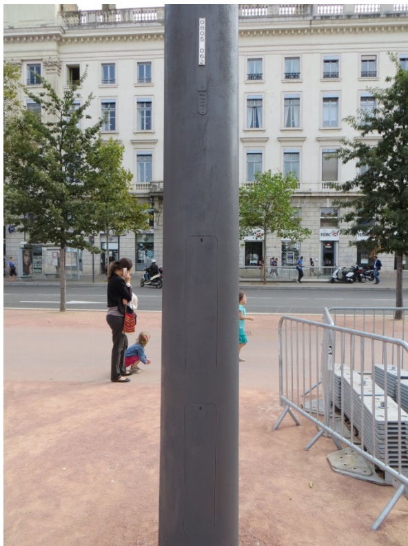
Koblingsluker og merkeskilt i metall.
