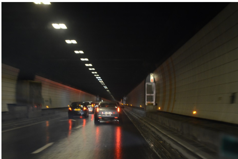
Nødstasjon og ledelys i tunnelen
