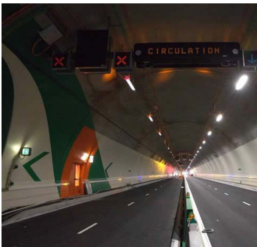
Nødtutganger og nødstasjoner i tunnelen
