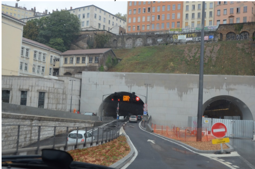
Tunnel de la Croix-Rousse under utbygging
