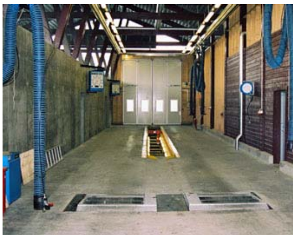
Kontrollspor med bremseprøveapparat og grav, Taraldrud kontrollstasjon ved E6, Akershus
