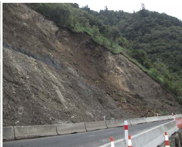
Bilde viser ryddet vegbane etter 12 dager
