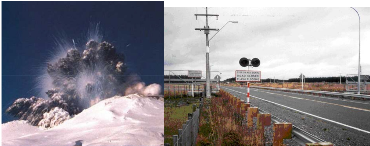
Figur 5: Det er brukt automatisk overvåking/vegstening for å sikre trafikken mot Lahars
