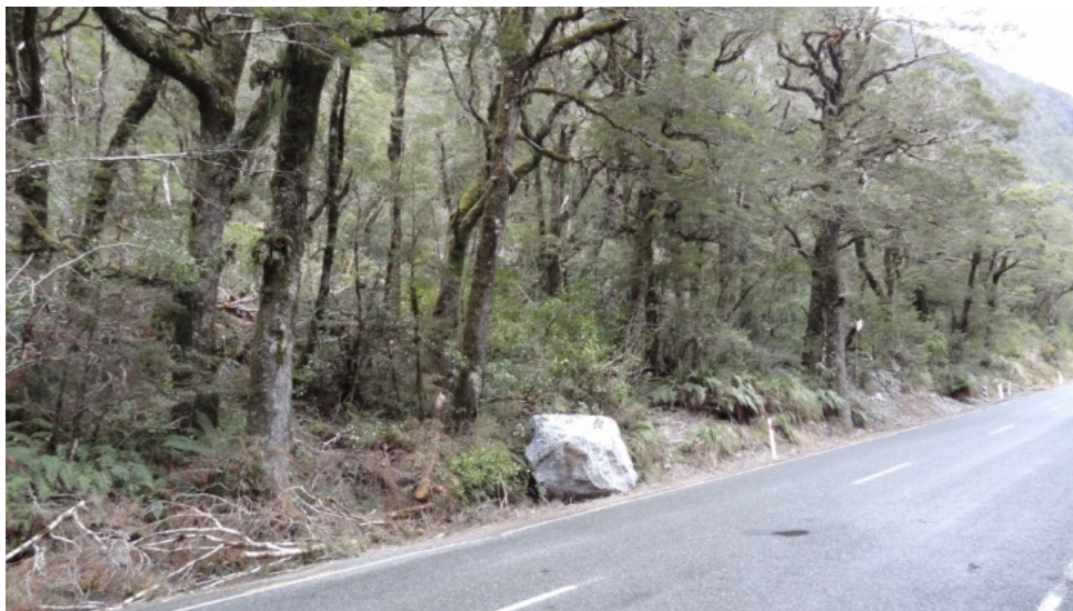
Figur 6: Steinblokk tett inntil vejen som løsnet fra fjellskråning/skjæring er forholdsvis vanlig på Ny Zealand
