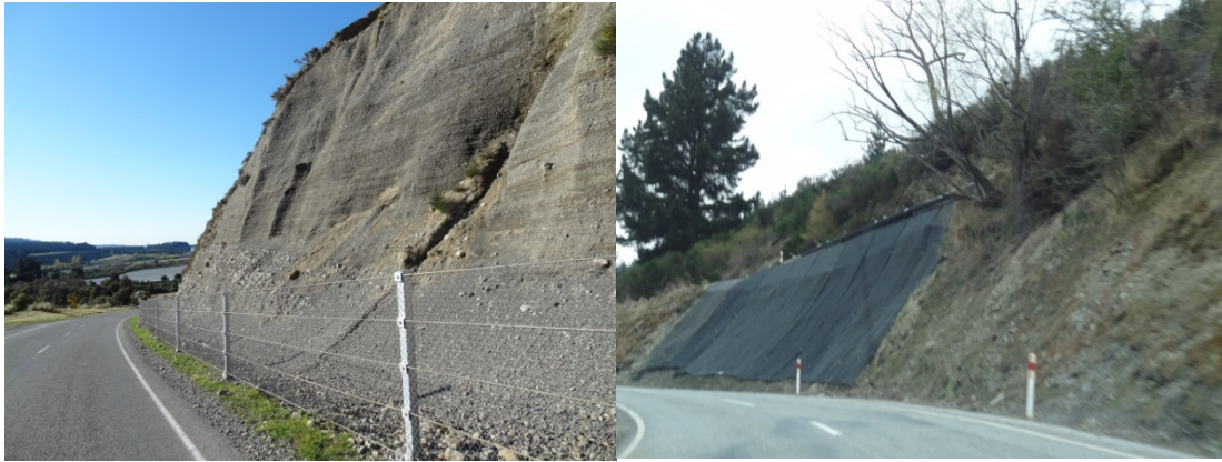
Figur 20: Ofte er det brukt mindre fanggjerder langs grøften for å ta mindre nedfall fra selve skjæringen. På få plasser er det også forskjellige former av geonett for å hindre erosjon.
