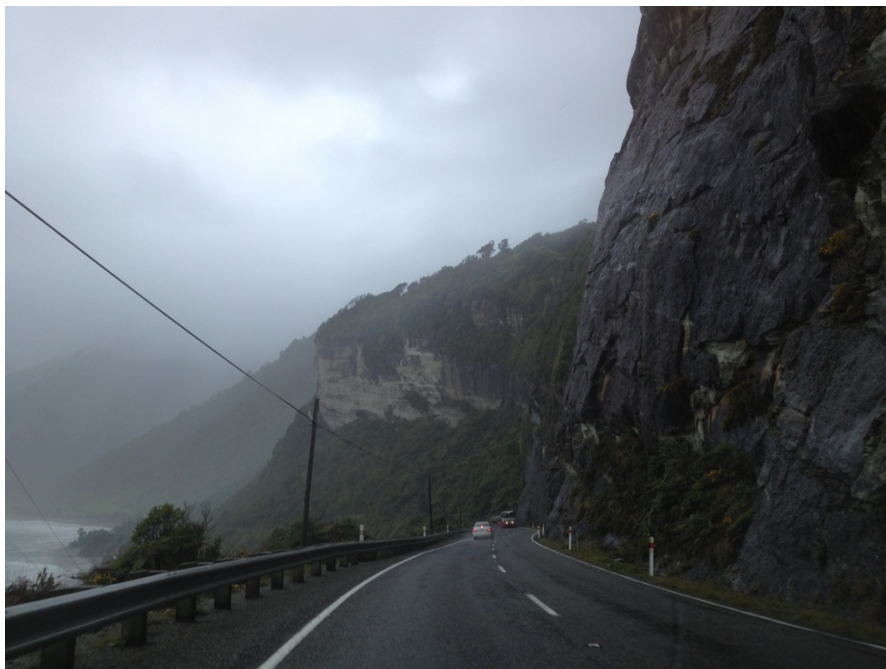
Figur 19: Det eksisterte også strekninger med mere Norge lignende fjell kvalitet. Vi så ingen eller svært lite sikring i disse bergskjæringer.
