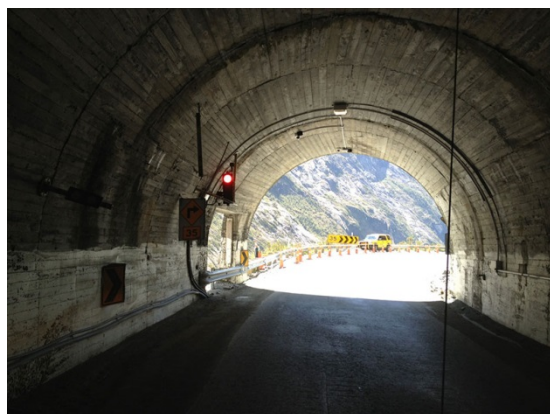
Figur 15 og 16: Stoppllys inne i tunnelen og overvåkningskamera for å kunne stoppe trafikken i tunnelen ved et eventuelt steinsprang/skred.
