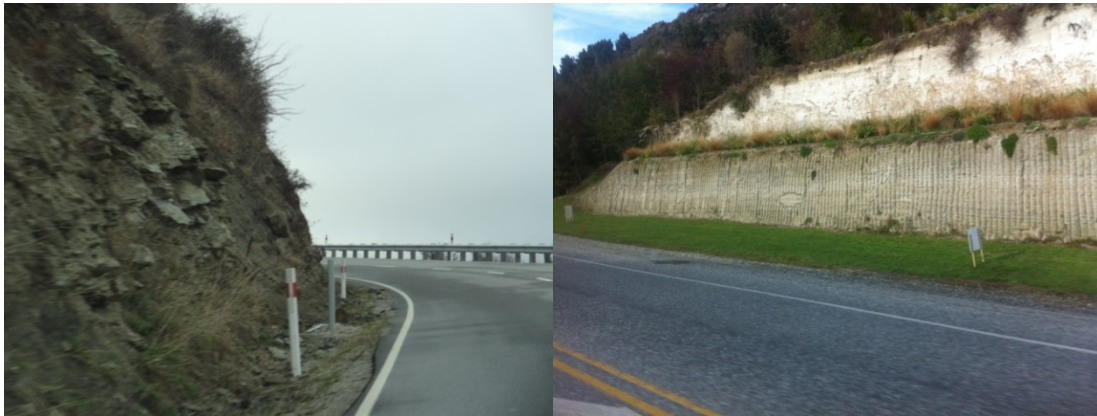
Figur 18: På grunn av mindre omfattende istider og erosjon har Ny Zealand mere gjenstående løssmasser og forvitret berg. På mange plasser så vi også permanente løsmasse/bergskråninger som ikke hadde vært akseptert i Norge
