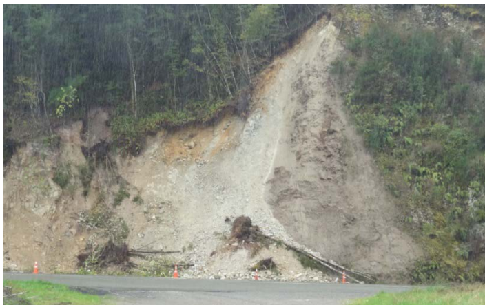
Figur 2: En hyppig årsak til vegstenginger og skred på Ny Zealand er jordskred og mindre utglidninger.
