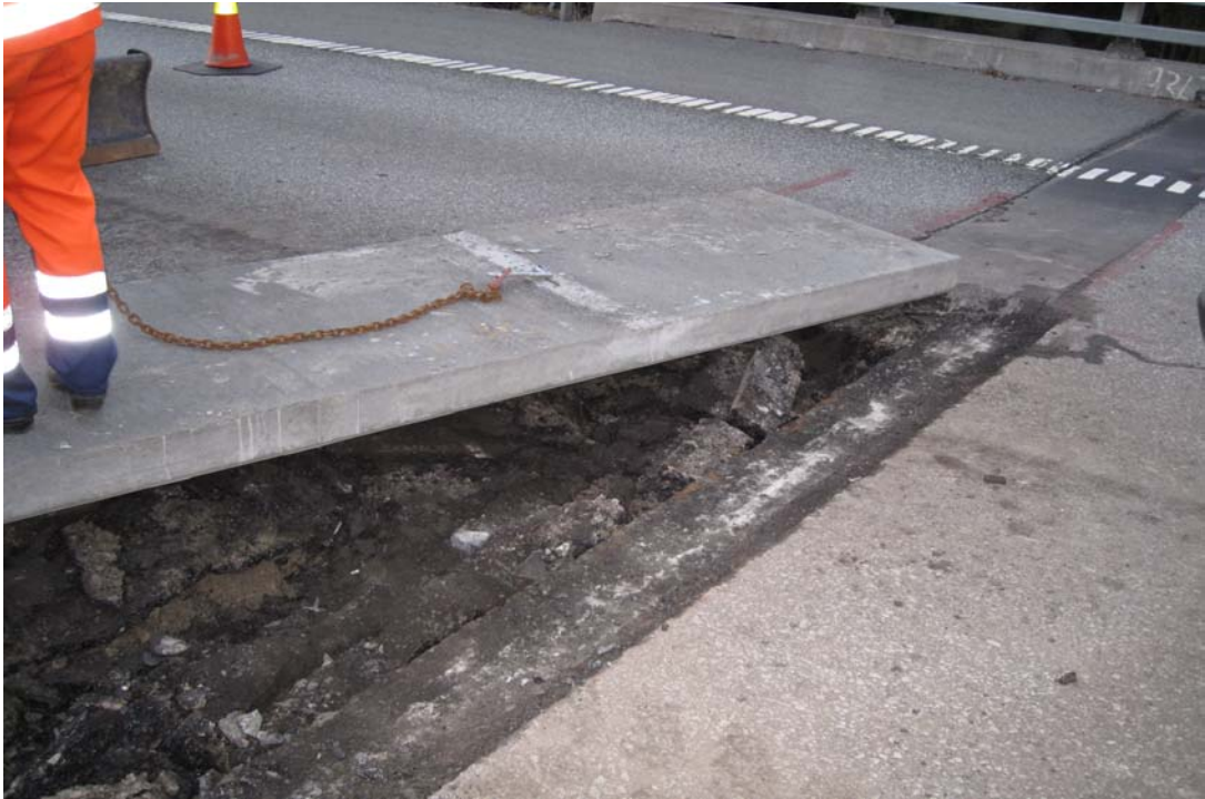
Tollerud Vest: Prøvelegging av betongelement
