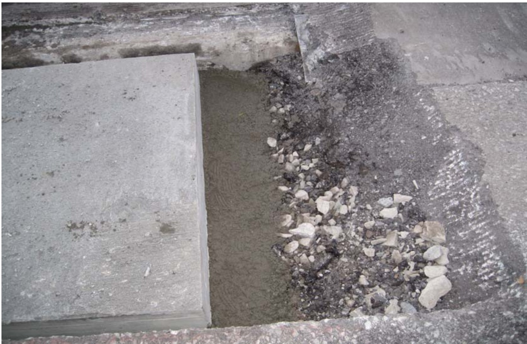
Tollerud Vest: Betongelementet lagt på en "seng" av jordfuktig mørtel
