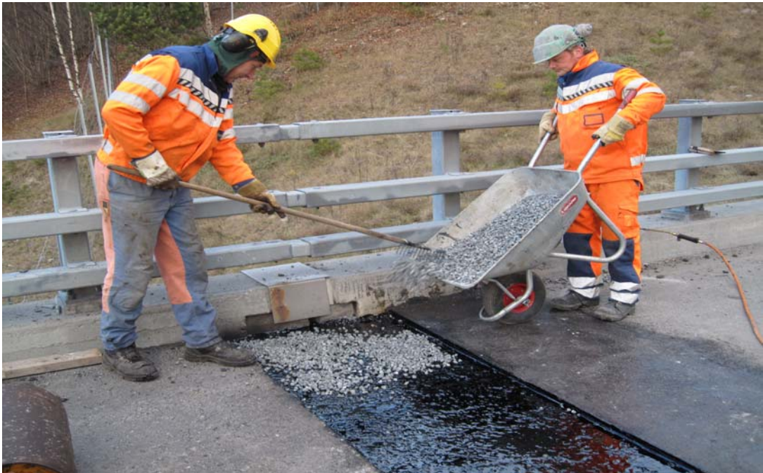
Tollerud Vest: Tarcofugen legges (oppvarmet tilslag)
