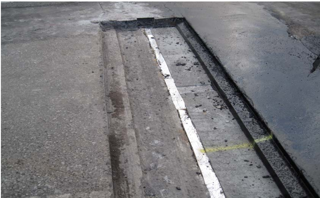
Tollerud Vest: Mesteparten av betongelementet er dekt av støpeasfalten. Det er nedtrapping på begge sider og isopor i spalteåpningen.
