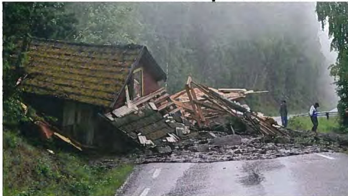
Hus tatt av flom langs riksveg 255 Vinstra-Skåbu.
