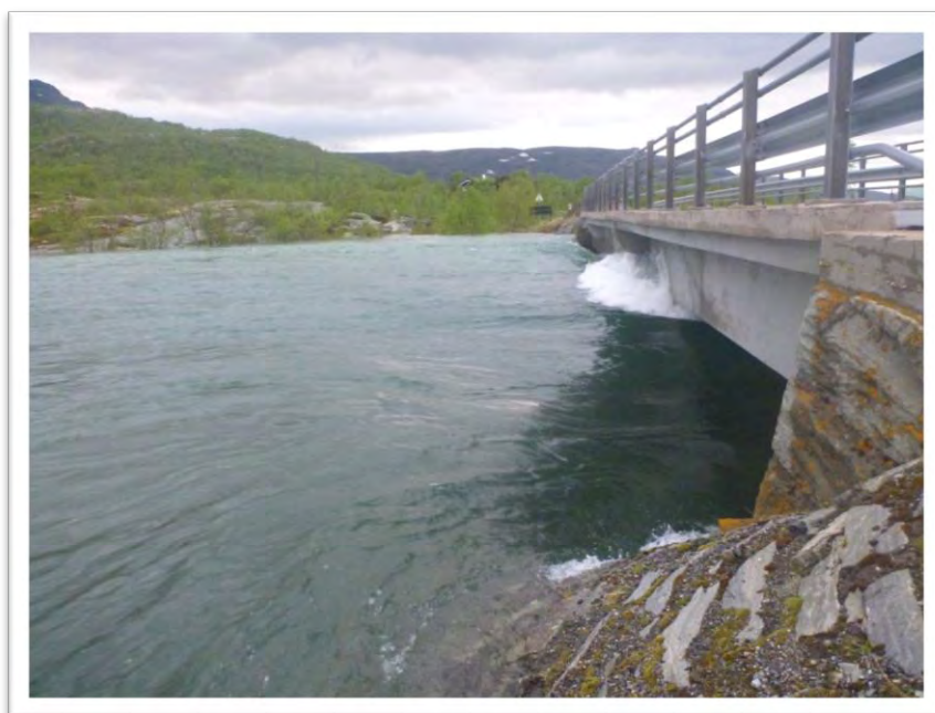
Bru på fv .51 ved Maurvangen. Foto: Niklas Eriksson, Svv.
