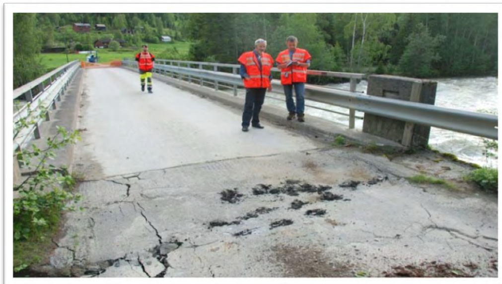
Inspeksjon av Storødegård bru i Heidal. Niklas Eriksson, Svein Håkon Nordlien og Jacob Jacobsen. Foto; Per Kollstad, Svv.
