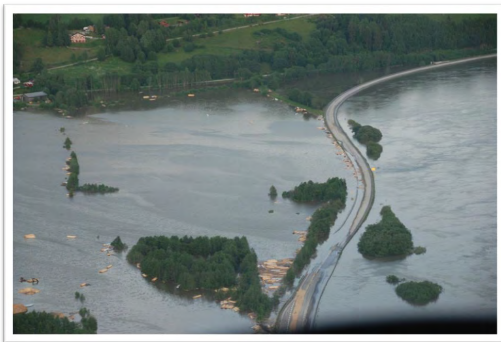
E6 ved Fåvang 13.juni. Foto: Per Kollstad, Svv
