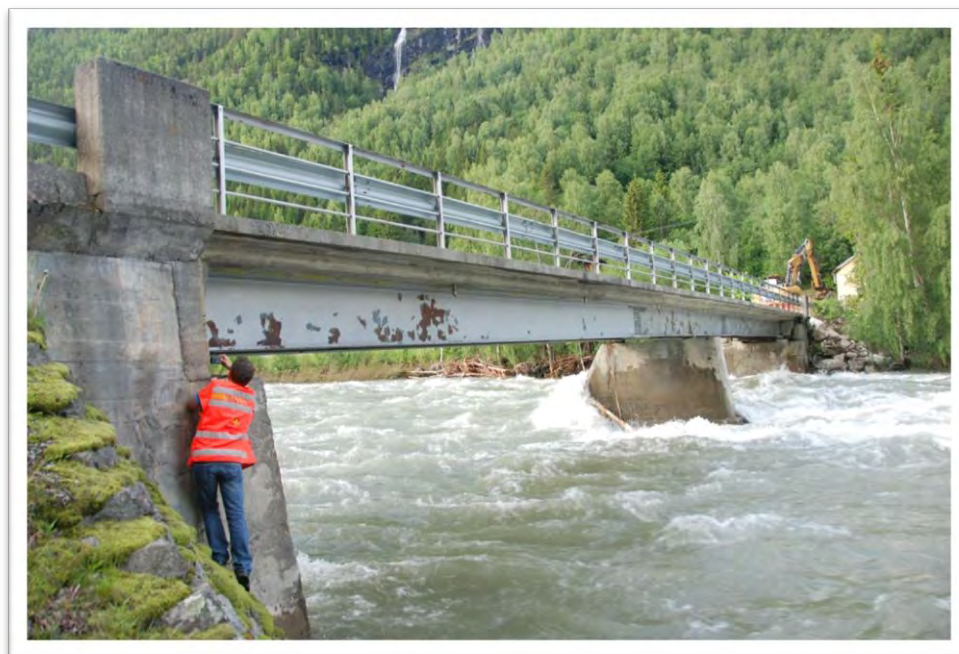
Jacob Jacobsen på bruinspeksjon i Heidal. Foto: Per Kollstad, Svv.
