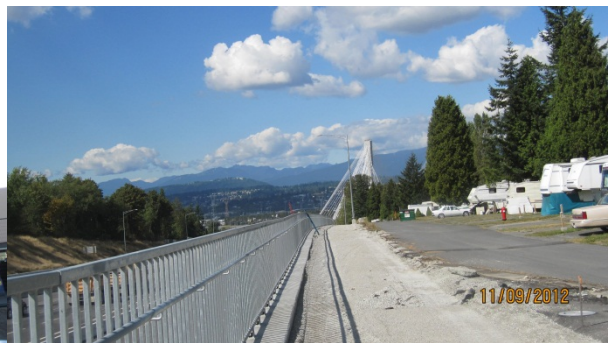
Forstøtningsmur i stedet for erverv av caravanområde.
