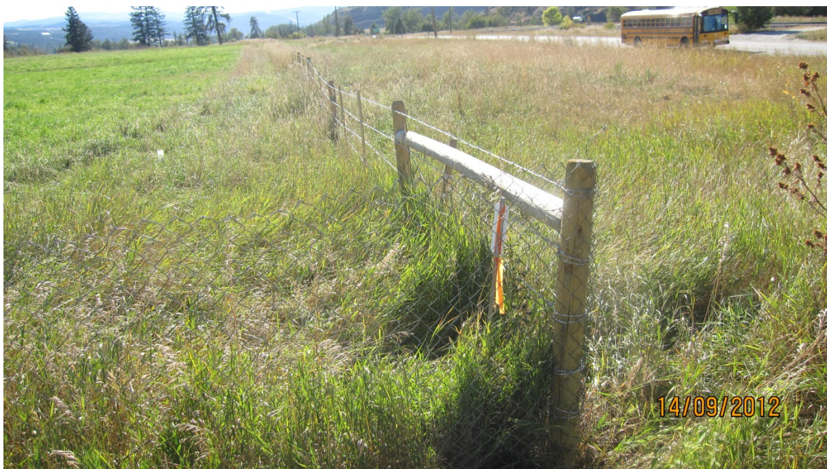
Inngjerding etter formålsgrensen i reguleringsplanen skjer før anleggsarbeidet tar til.
