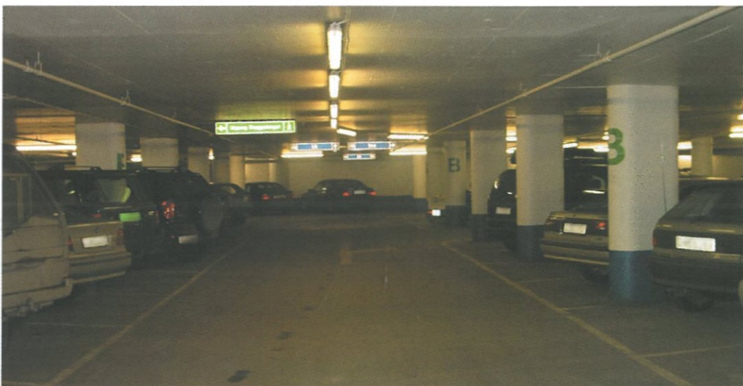
Belysningsarmaturen er montert sentrisk i forhold til kjørebanelen og angir dermed denne. Armaturplasseringen virker også mindre blendende enn om den hadde stått på tvers.
