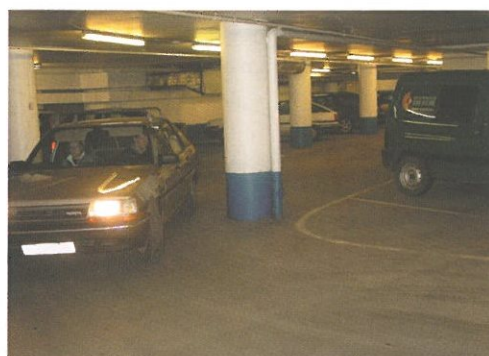
Søylar står ute i kjørebanelen.
