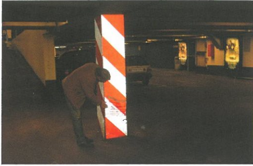
Uheldig plassert søyle.
