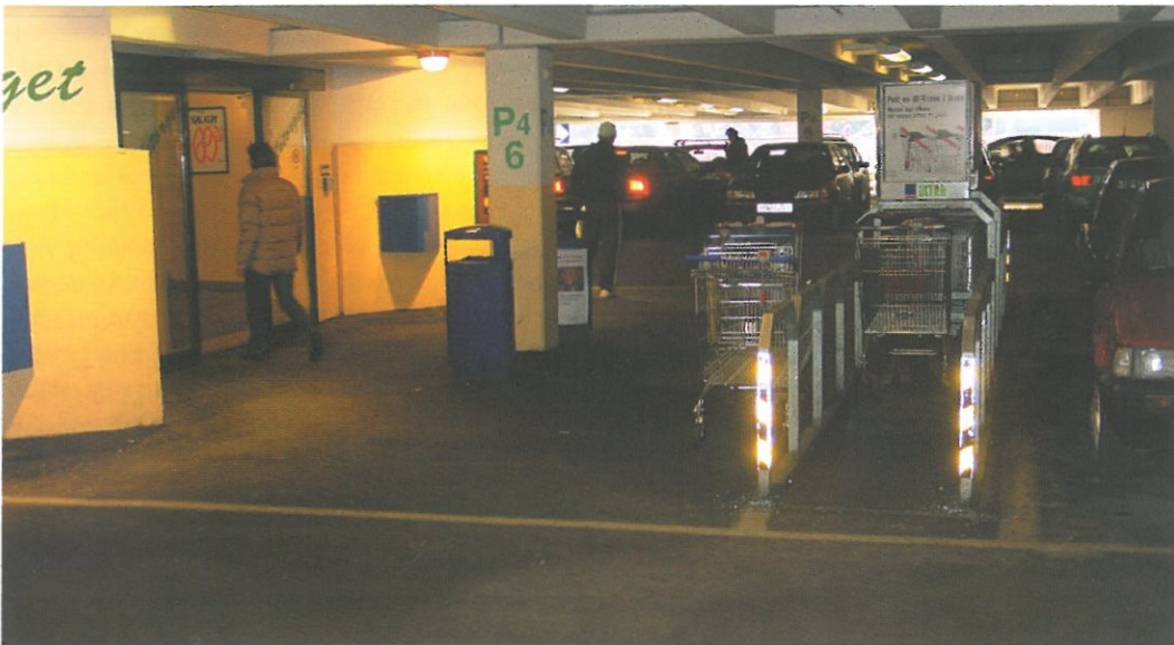
God løsning på separert bil- og gangtrafikk ved inngang til heis og trapperom. Handlevognene har oppstillingssone innenfor gangtrafikkarealet.
