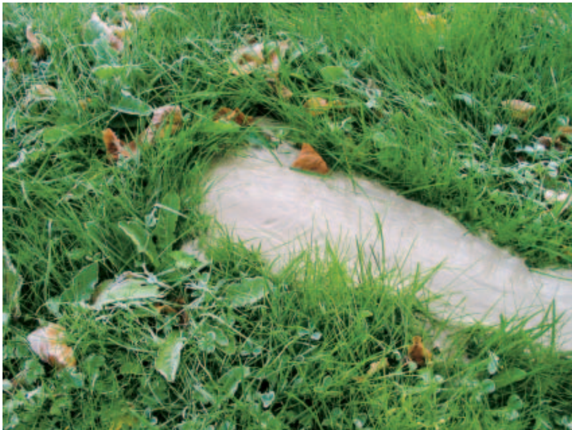
Bilde 5.1 viser utgang i dagen og er et eksempel på masse med for høyt v/c-forhold i forhold til overdekning og bergart (foto: Kveen).
