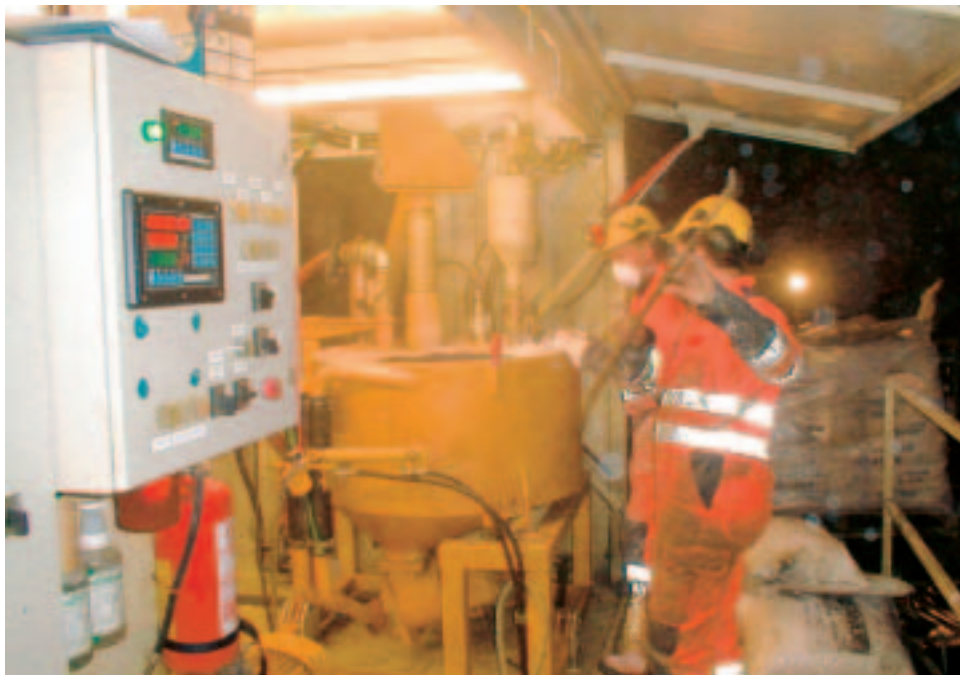
Bilde 8.1 viser en moderne injeksjonsrigg som er viktig for HMS og for å få til et godt injeksjonsresultat (foto: Kveen).
