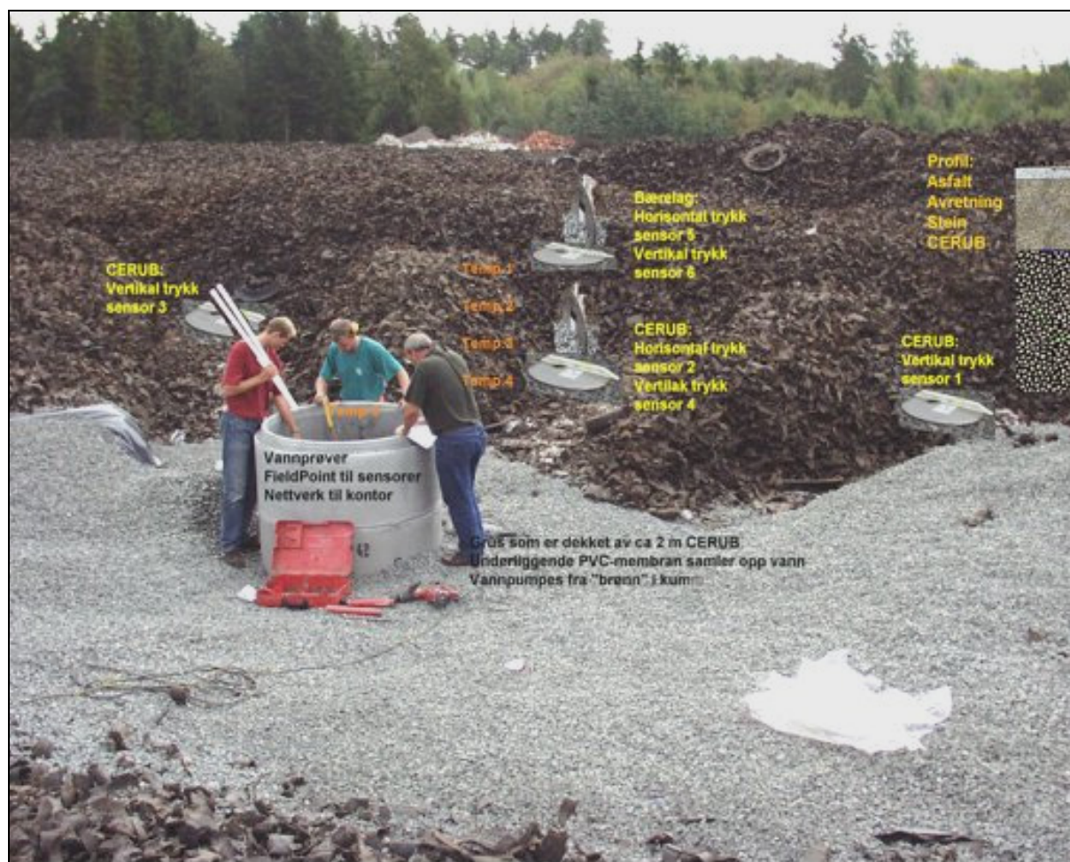
Figur 3: Overvåkingsstasjon "Kum 1" ved Solgård er anlagt oppå et basseng bestående av en PVC membran dekket med grusmasser. Det er etablert en brønn i bunnen av "Kum 1". Det er utført overvåking av vannkjemi, jordtrykk og temperatur. "Profil" til høyre i bildet viser oppkuttede bildekk (CERUB), stein, avretting og asfalt som i dag dekker overvåkingsstasjonen. I overvåkingsperioden (2001-2003) var ikke asfallet etablert.
