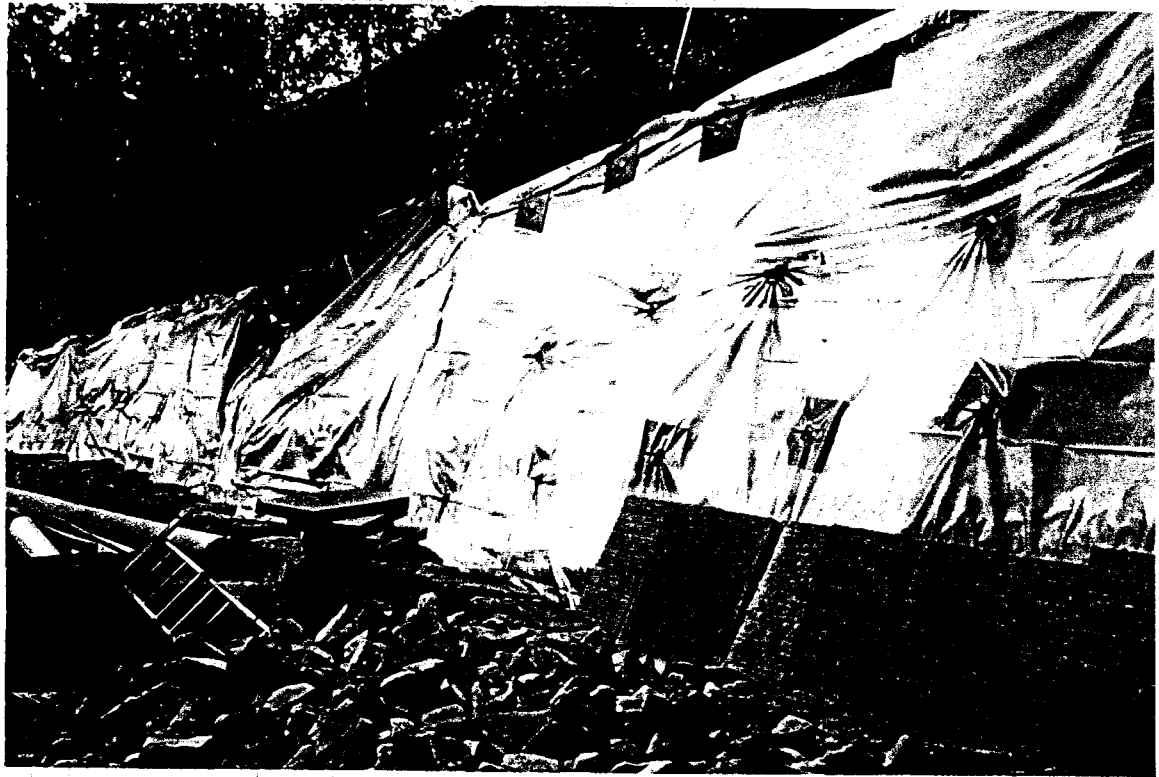
FV58 Vassenden. Ved begynnelsen av muringa.
