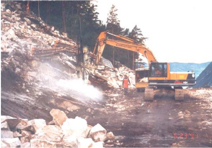
Fig. 14: Graving av skjæring i finstoffattig ur på skråfjell. Arbeidssikring med 25 mm kamstålbolter i fjell og med bakenforliggende tømmerstokker. Rv. 53 Naddvik-Fodnes, Sogn og Fjordane. (Foto E. Husabø, vegkontoret i Sogn og Fjordane.)
