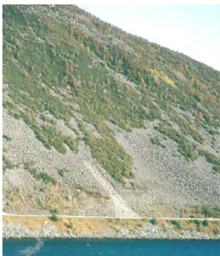
Fig. 11: Ras juni 1991 i Haddalsura, rv. 653 i Møre og Romsdal. Rasårsak var trolig skjerpning av vegskjæring fra 1:1,4 til 1:1,2 i forbindelse med vegutvidelse. Raset har begynt med utfall av stein/blokker fra øvre skjæringskant, og har så spredt seg oppover i ura på grunn av stadig nye utfall (ravelling). (Foto B. Wivestad, vegkontoret i Møre og Romsdal.)
