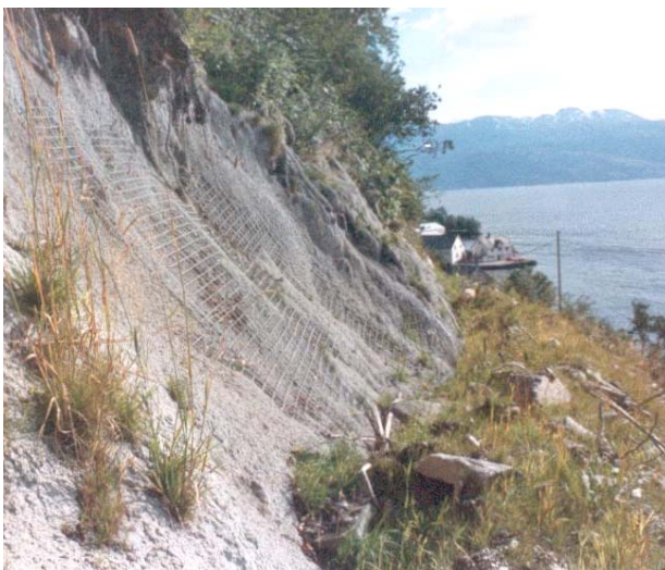
Fig. 17a: Arbeidssikring av skjæring i finstoffrik ur med nettarmert sprøytbetong. Rv. 7 ved Fyksesund, Hardanger, Hordaland.
