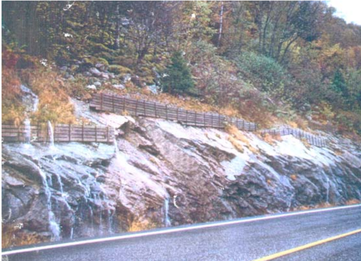
Fig. 18: Sognemur. Skal hindre erosjon i løsmasseskjæringer på toppen av fjellskjæringer. Rv. 55 nær Høyanger, Sogn og Fjordane.
