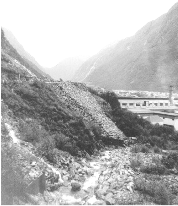
Fig. 19: Permanent sikring med ordnet steinfylling, Høyanger, Sogn og Fjordane.
