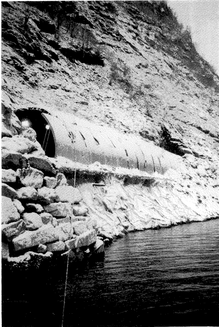
Bilde 20 Fundament og skråning ferdig sikret.
