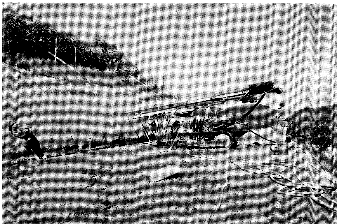
Bilde 4 Boring av hull for første stegrad (3. juni 1993).
