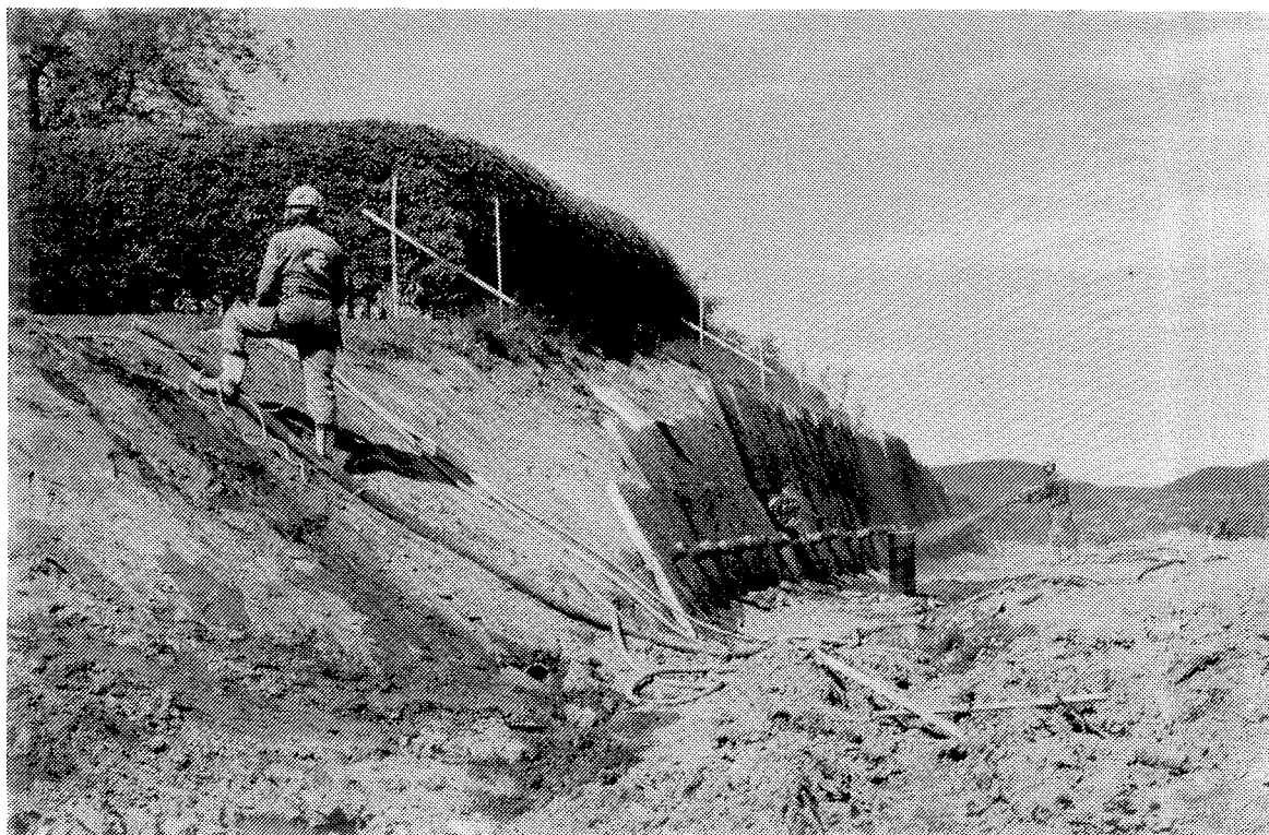
Bilde 3 Første nivå med kombinerte drens- og isolasjonsplater påføres 1.lag av sprøytebetong. Merk rørstussene for lettere gjennom-boring ved stagsetting og enklere kontroll av tykkelse på betongen.
