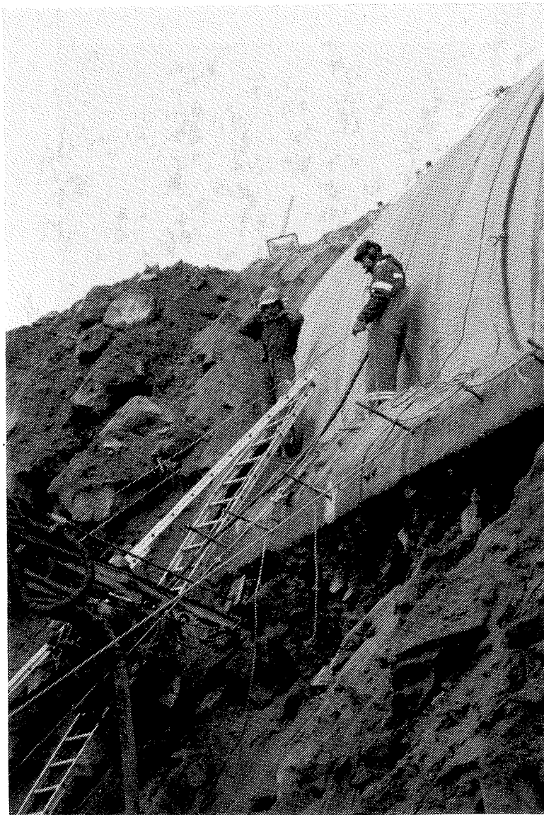
Bilde 18 Plasstøpt del av fundamentet for rasoverbygget er sikret. Boring pågår for første stegrad i skråningen.
