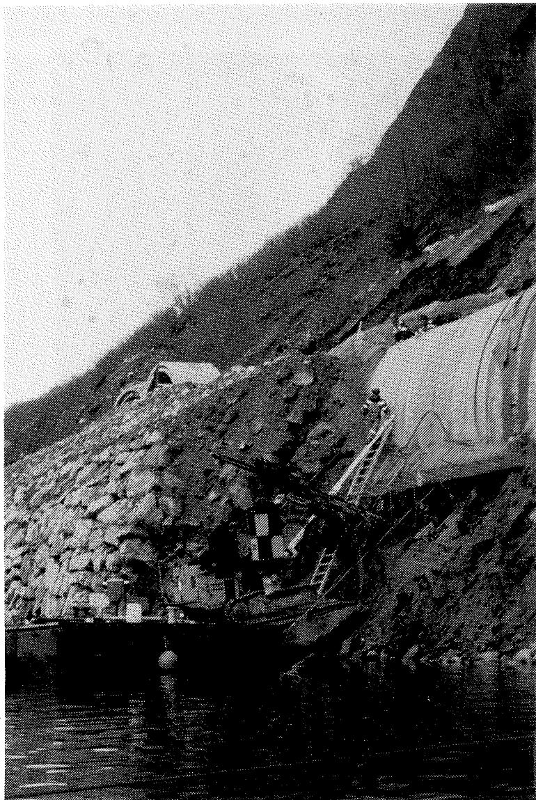
Bilde 17 Jordnagling pågår med sikring av skråningen nedenfor rasoverbygget.
