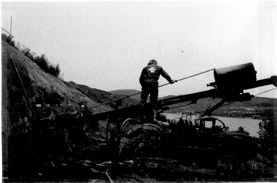
Bilde 5 Kamstålboltene installeres med avstandsholdere i foringsrør.
