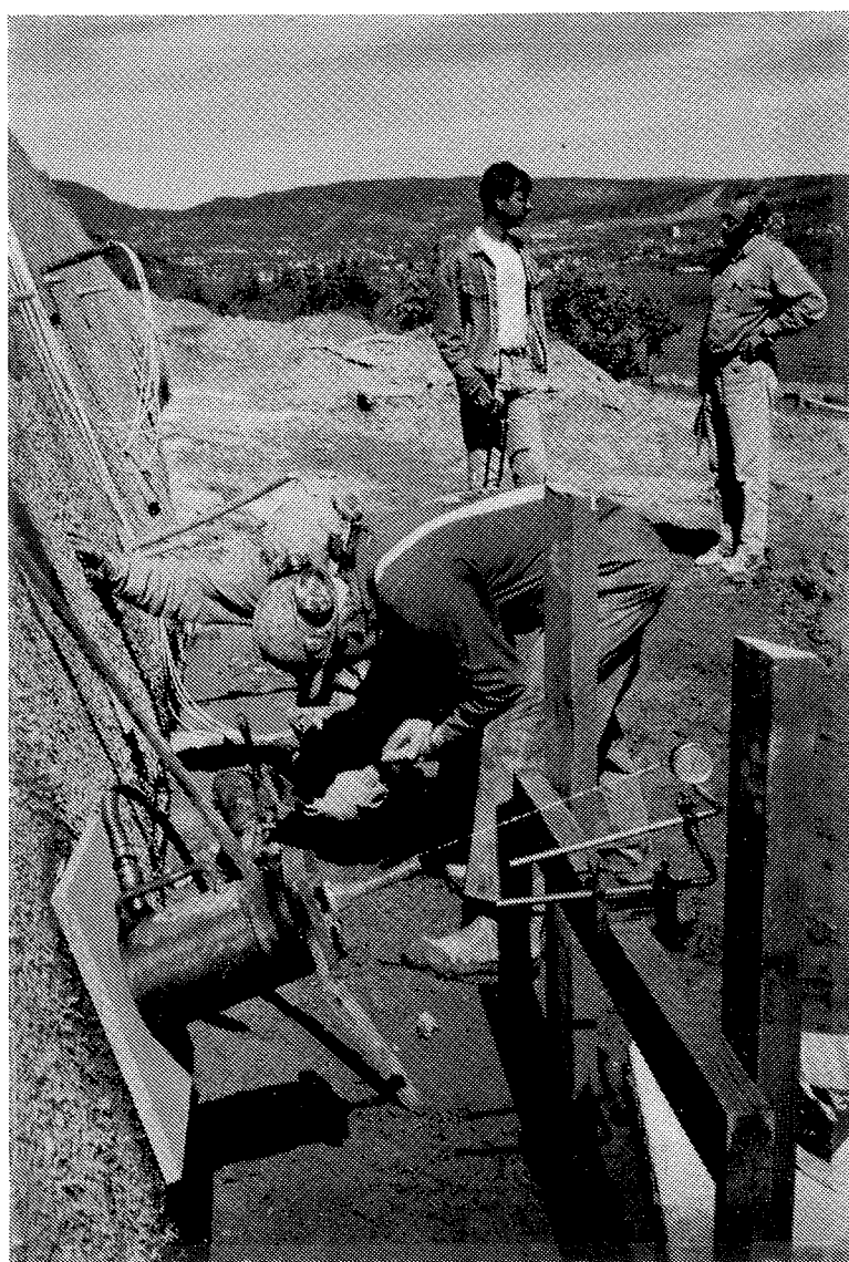
Bilde 8 Detalj av oppsett under prøvebelastning i 2. stegrad (3. juni 1993).
