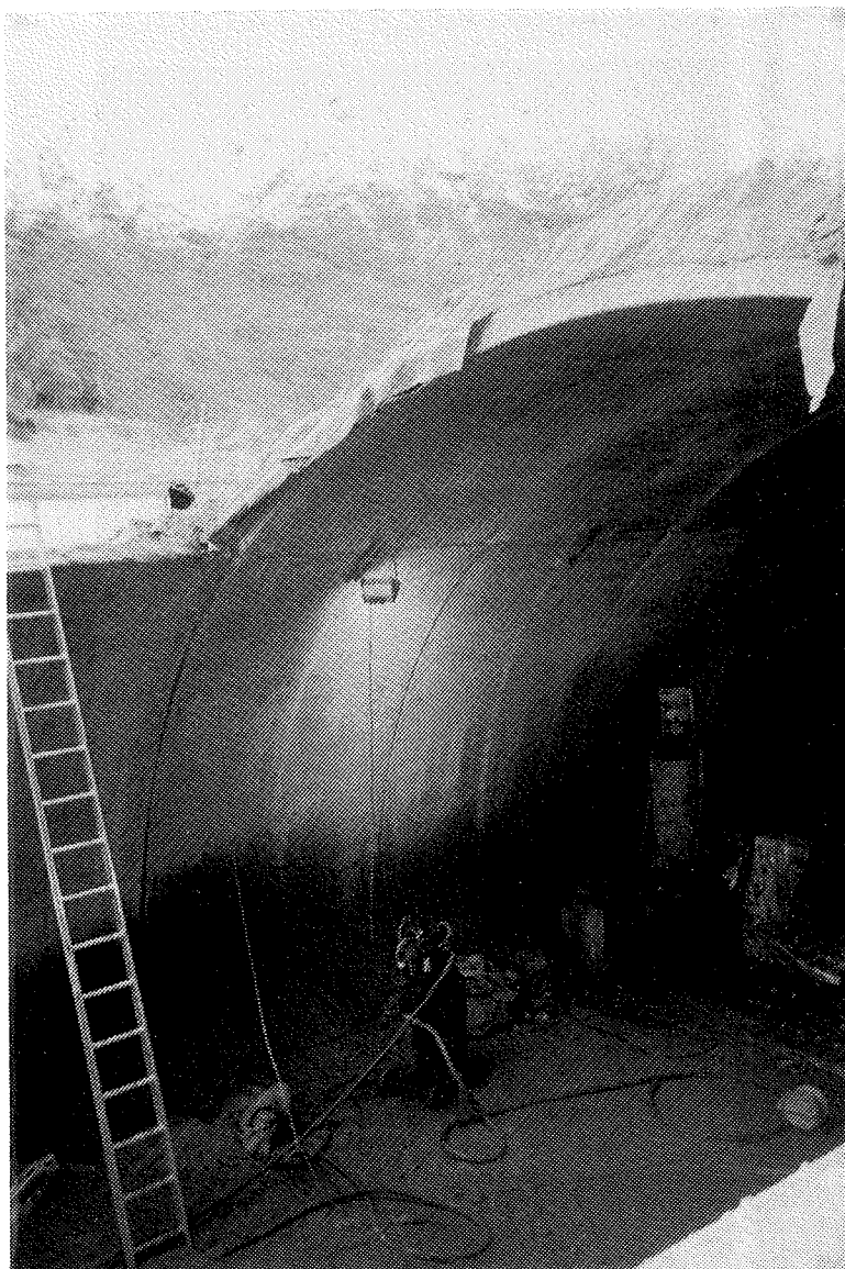
Bilde 19 Fjernstyrt injeksjonspumpe inne i rasoverbygget. Merk skjøtene i betongelementene for rasoverbygget.
