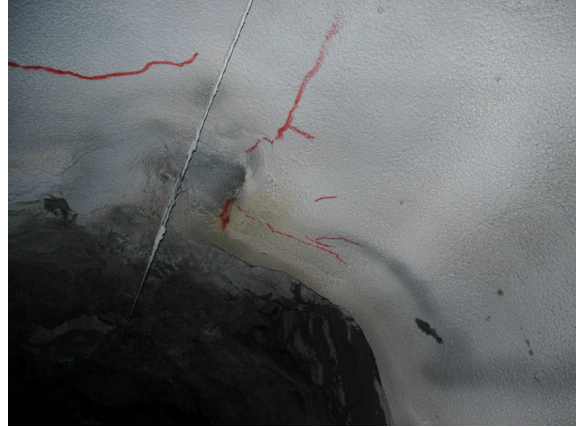
Figur 1 Feltet sett nedstrøms før brannen. Markering av større riss og sprekker. Rissvidder 1-3mm. Vannlekkasjen i a) er ca 2m fra start felt. Foto: Morten A. Forsberg.
