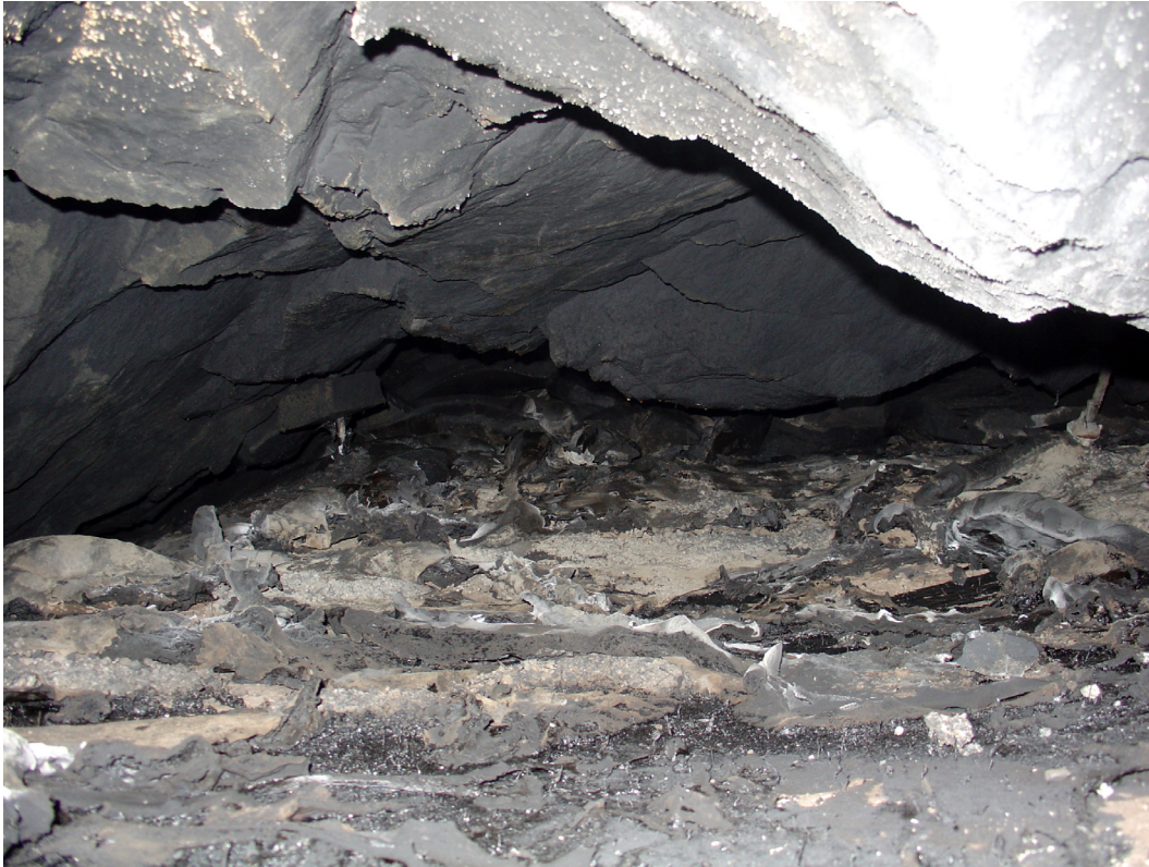
Figur 13 Hulrommet bak PE-skummet før nedpigging. Småfallent fjell samt rester av gammel sprøytebetong lå oppå restene av PE-skummet. Bildet er tatt ca 11m fra oppstrøms ende (ser oppstrøms)
