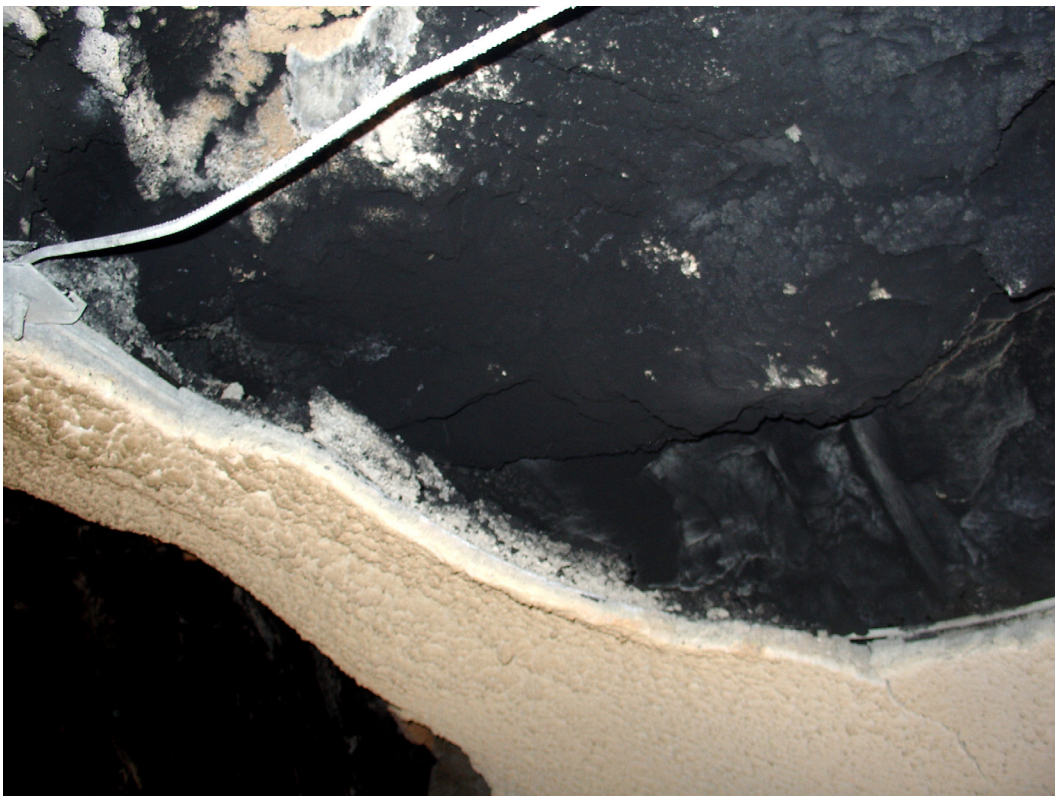
Figur 14 Fjellet i hulrommet bak PE-skummet etter nedpigging. Fjellet er tilsynelatende dekket av sot (ser nedstrøms)
