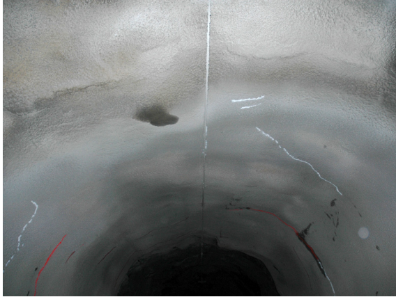
Figur 1 Feltet sett nedstrøms før brannen. Markering av større riss og sprekker. Rissvidder 1-3mm. Vannlekkasjen i a) er ca 2m fra start felt. Foto: Morten A. Forsberg.
