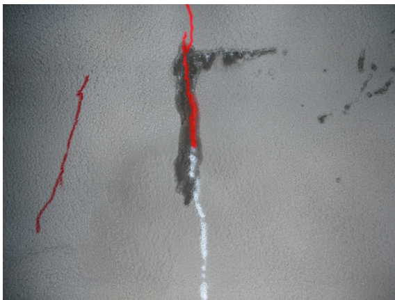
Figur 1 Feltet sett nedstrøms før brannen. Markering av større riss og sprekker. Rissvidder 1-3mm. Vannlekkasjen i a) er ca 2m fra start felt. Foto: Morten A. Forsberg.
