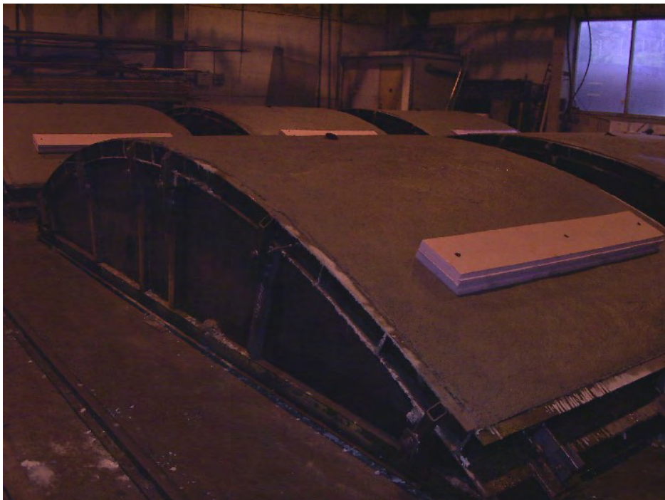
Foto 2: Tunnelelement etter at overform er fjernet.
