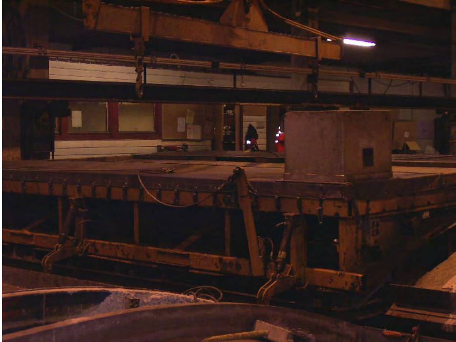
Foto 1: Støpeform med underform og flyttbar overform - før utstøping.
