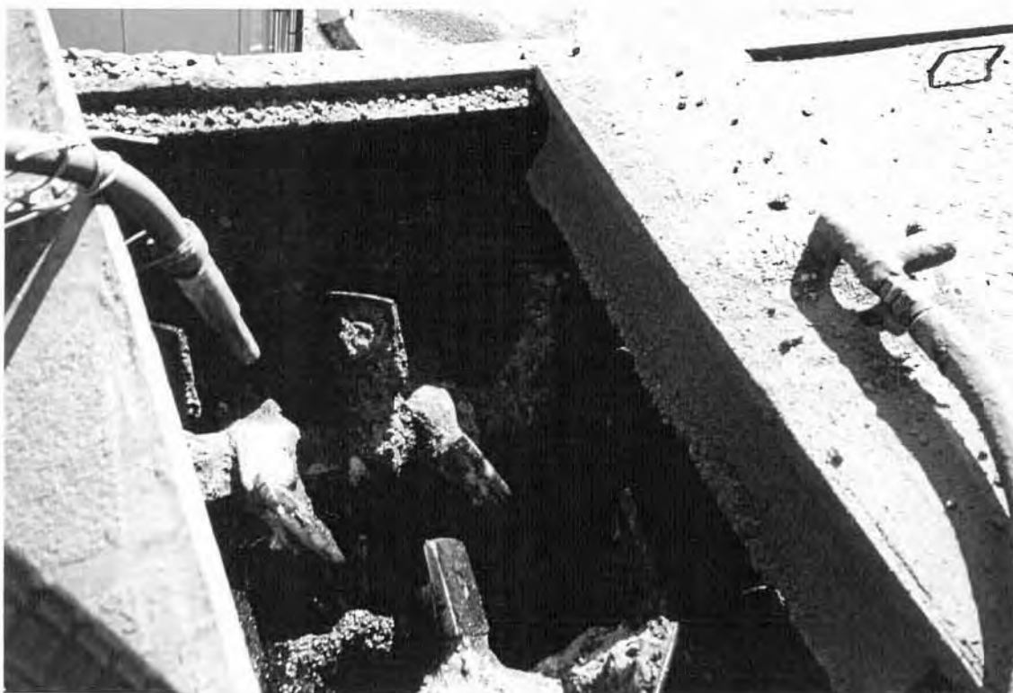
FIGUR 28 Tilsetting av vann til knustmassen foran i blanderen før emulsjons-påsprøyting (tverrstilt bom med sprededyser for emulsjon ses på lokket over blandekammeret)
