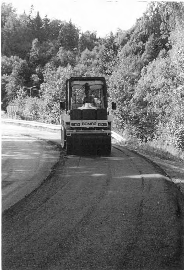
FIGUR 16 Avsluttende glattvalsing av Gja-dekke med slettvals, Fv 502
