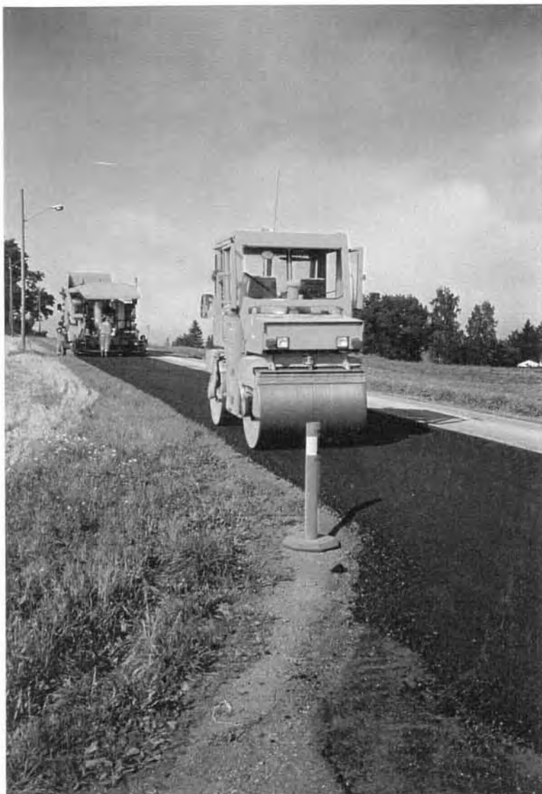
FIGUR 22 Valsing av nylagt Gja, Fv 78
