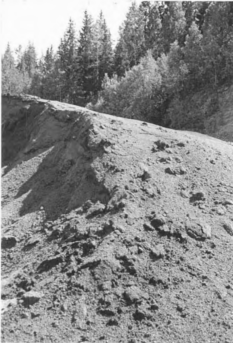
FIGUR 4 Lagerhaug 0-8 material (sammenkitting og klumpdannelse)
