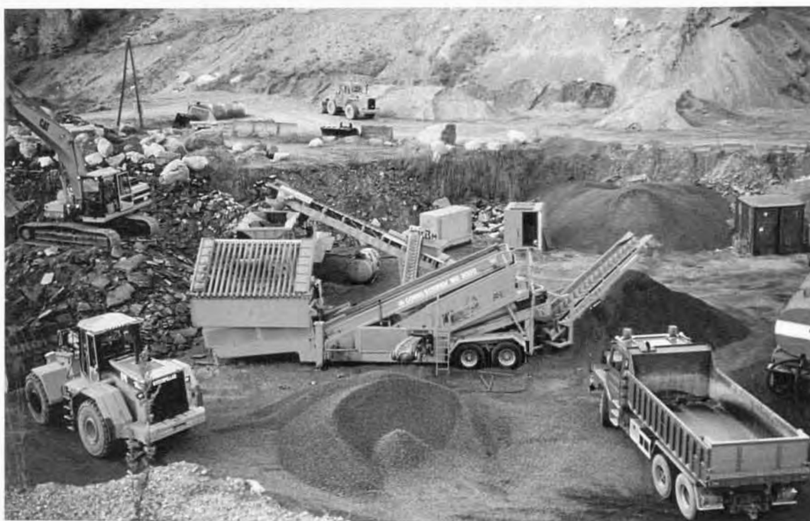
FIGUR 27 Knusing og fraksjonering i Egge grustak. Innlasting av flak med gravemaskin
