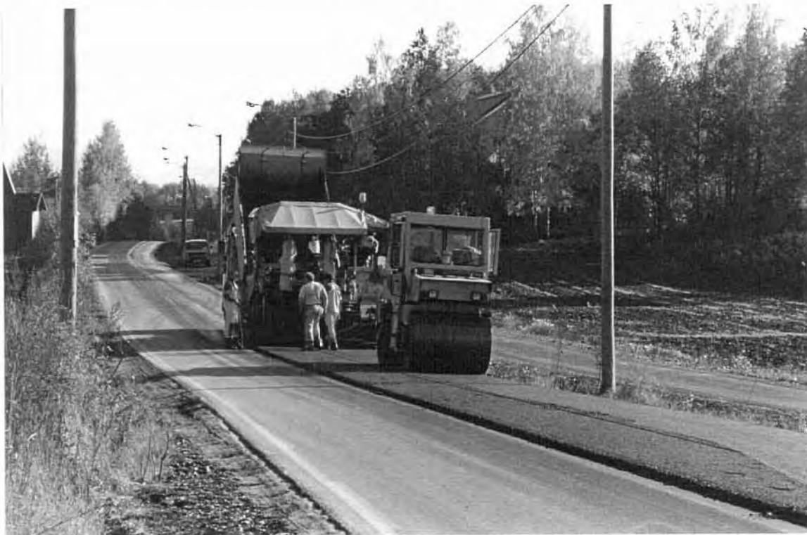
FIGUR 31 Utlegging av Gja, Fv 21 Buskerud
