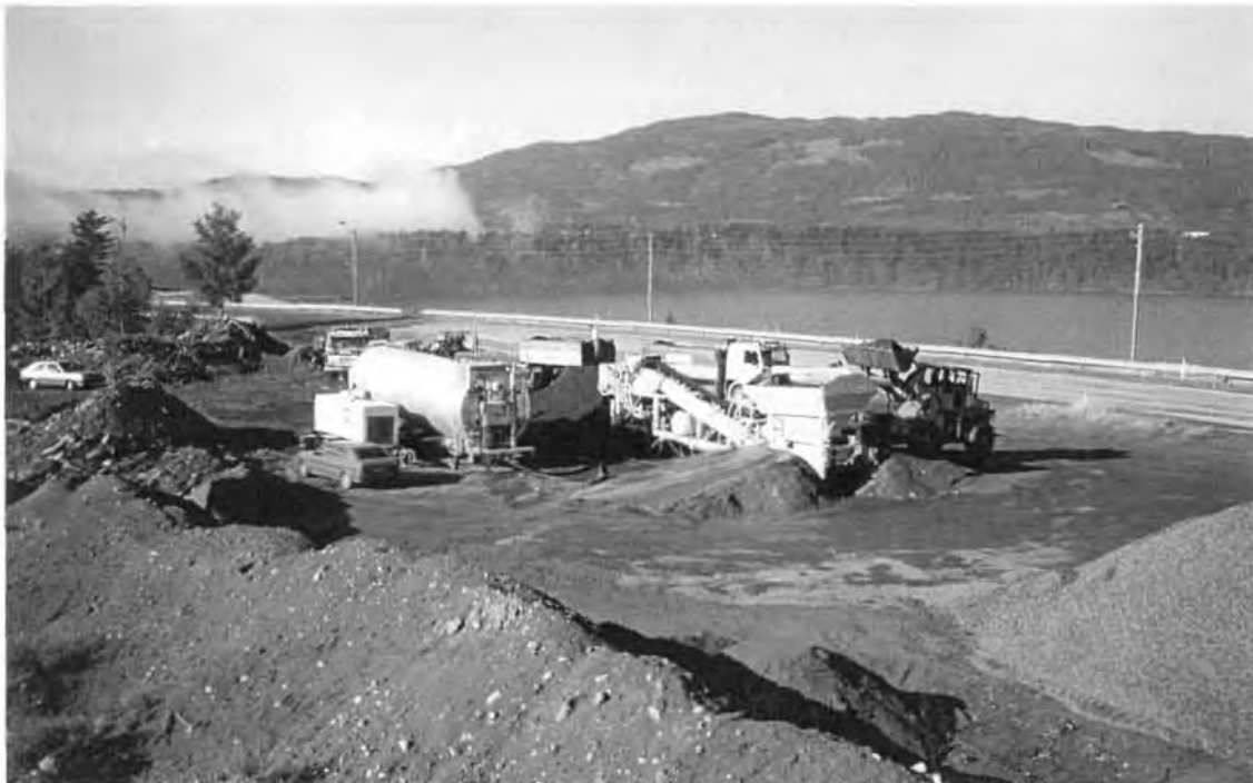
FIGUR 10 Oppstilling av blandeverk - "KS-50", Langset i Akershus
