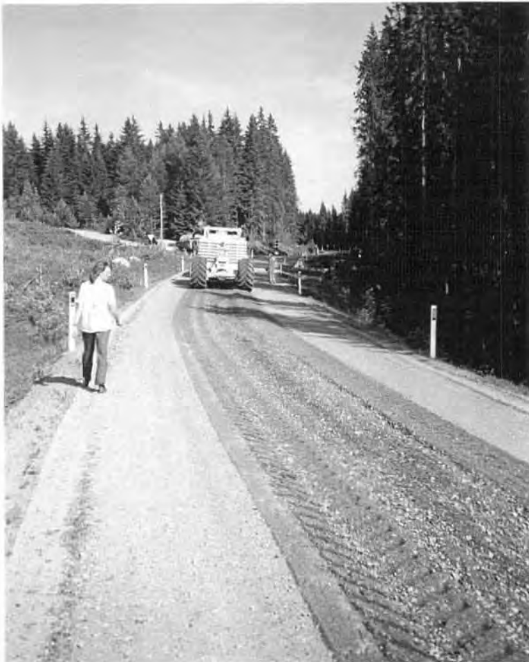
FIGUR 2 Fres i arbeid med dypstabilisering på Rv 200 i Hedmark
