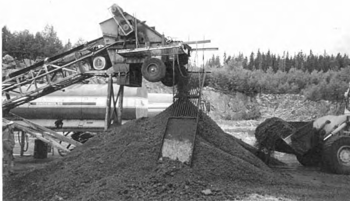
FIGUR 6 Montering av rist for fjerning av klumper i ferdig blandet material
