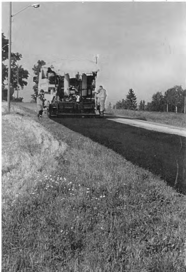
FIGUR 21 Utlegging av Gja, Fv 78
