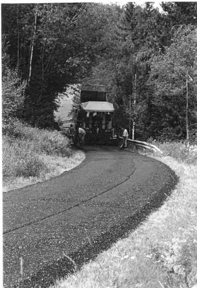
FIGUR 36 Utlekking av Gja-dekke, Fv 209 Vestfold
