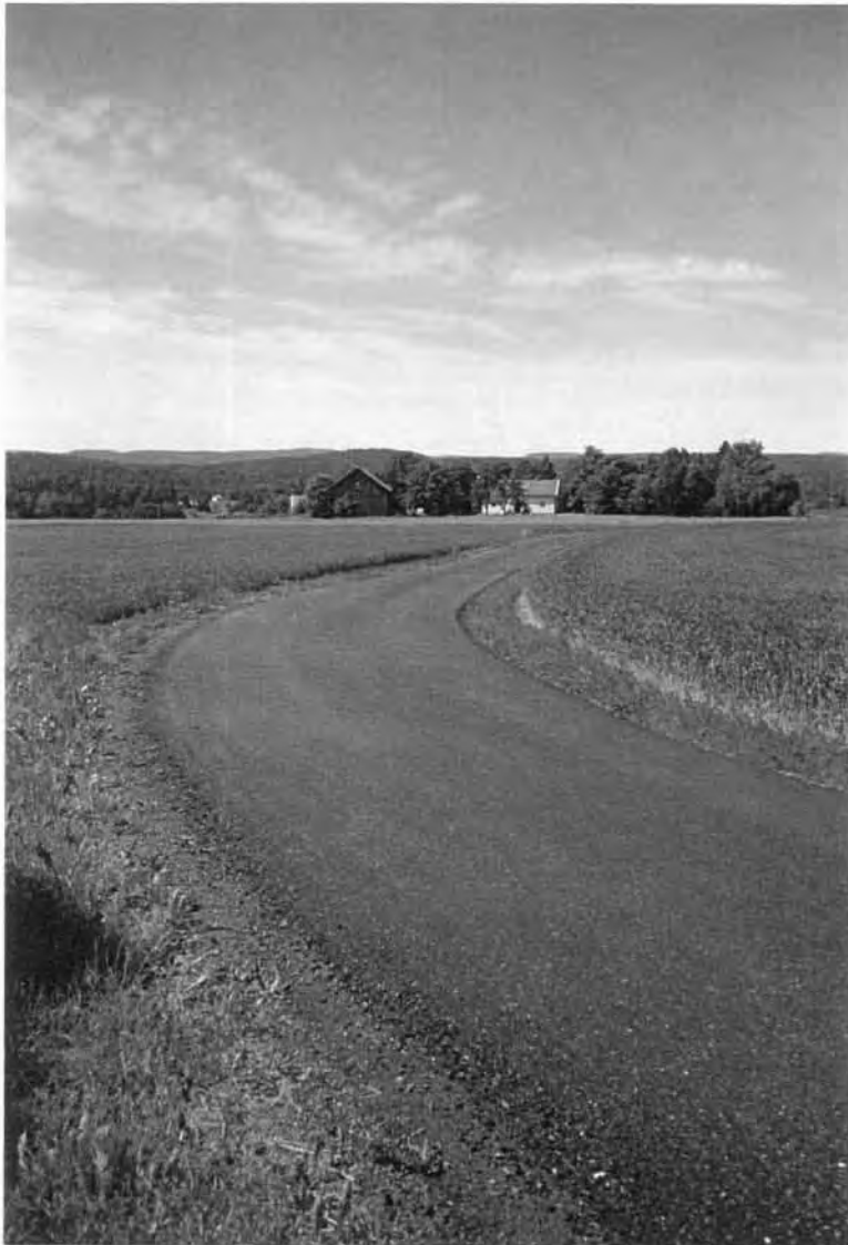
FIGUR 40 Dekke med kaldblandet Gja, Fv 665 Vestfold
