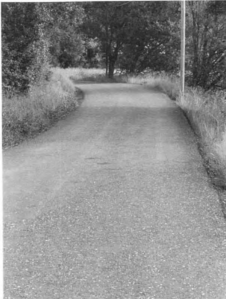
FIGUR 47 Nylagt Gja-dekke, Dyngelandsveien i Bergen
