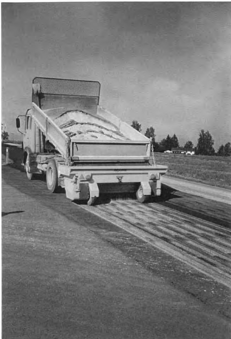
FIGUR 23 Avstrøing med finsand på nylagt Gja, Fv 78
