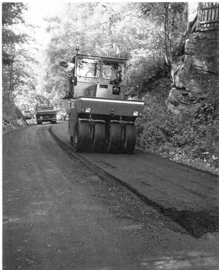
FIGUR 15 Valsing med gummi-hjulsvals (her på opprettingslaget), Fv 502
