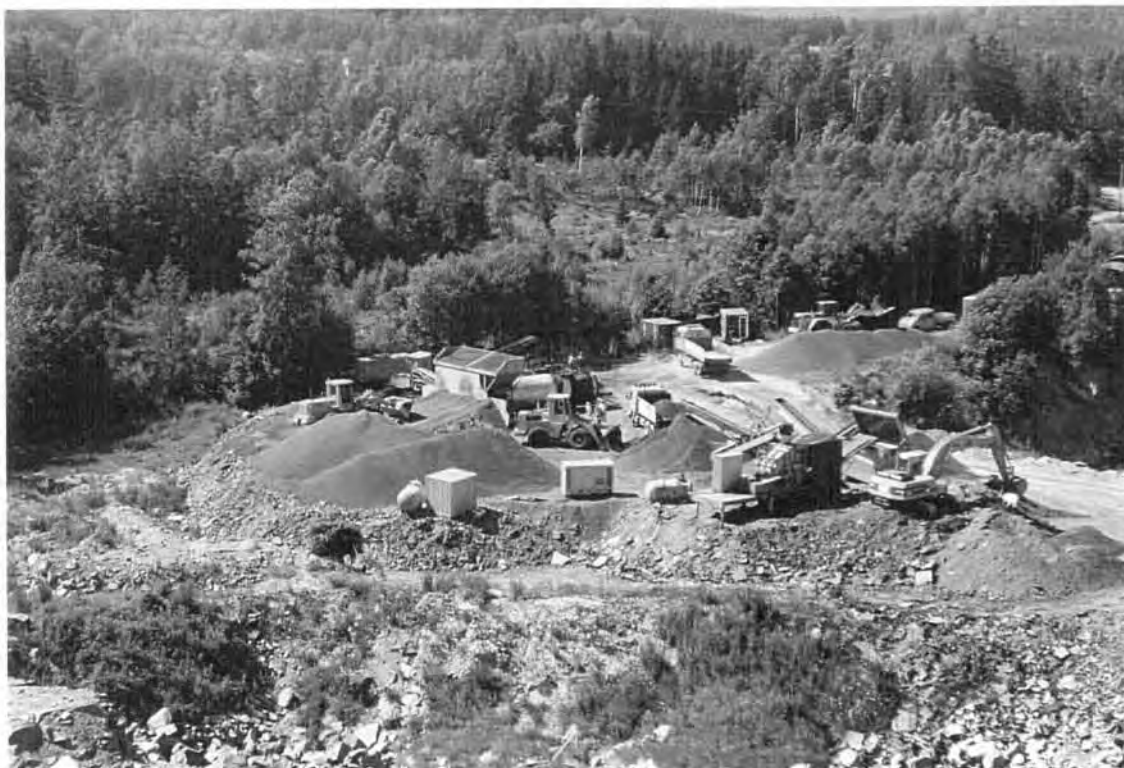
FIGUR 34 SVV Buskerud i gang med knusing av flak og blanding av kald Gja, Fokserød pukkverk Vestfold
