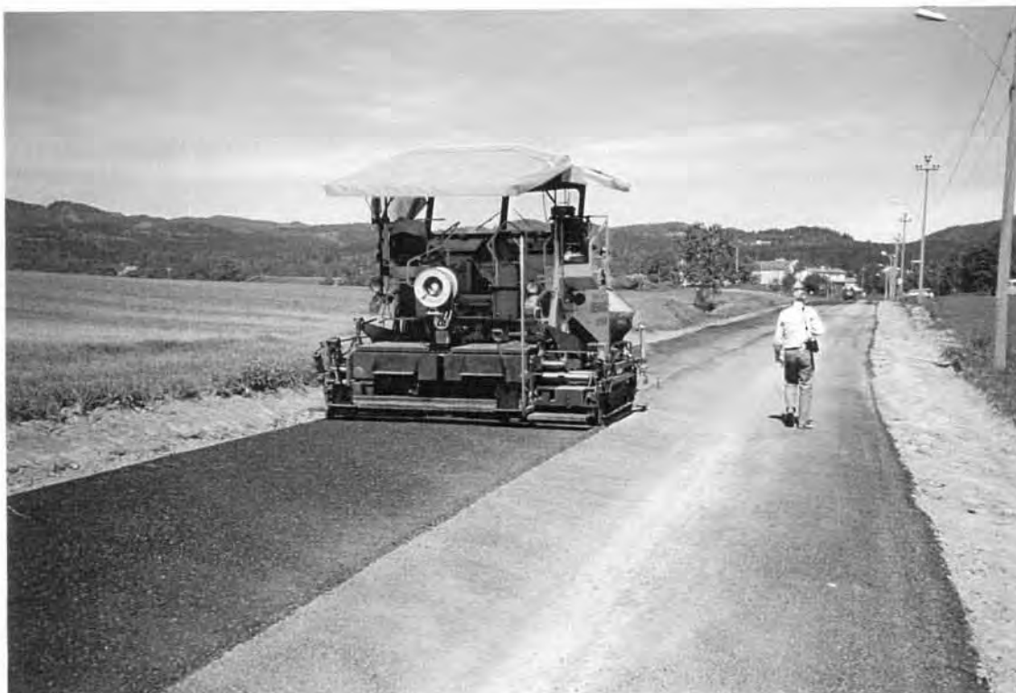
FIGUR 43 Utlegging av Gja 16 på Sørkedalsveien, Oslo
