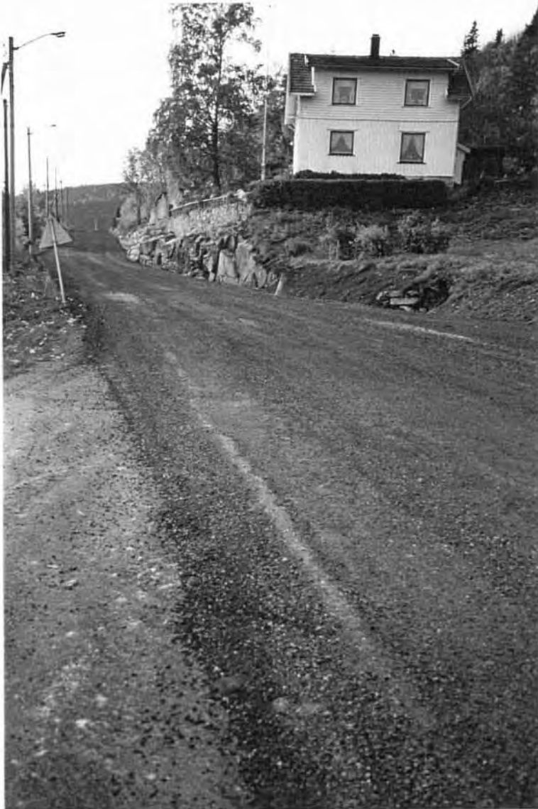
FIGUR 30 Opprettingslag av Gja utlagt med veghøvel, Fv 21
