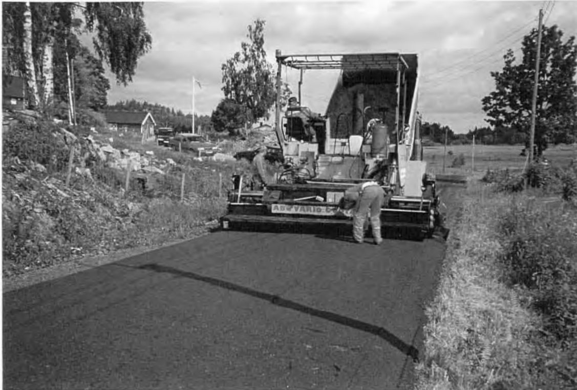
FIGUR 38 Utlegging av Gja-dekke, Fv 560 Vestfold. Beltegående utlegger fra Veidekke Asphalt
