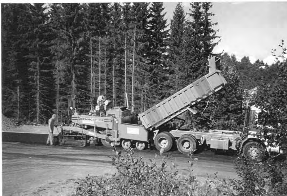
FIGUR 13 Utlegging av Gja, Fv 502
