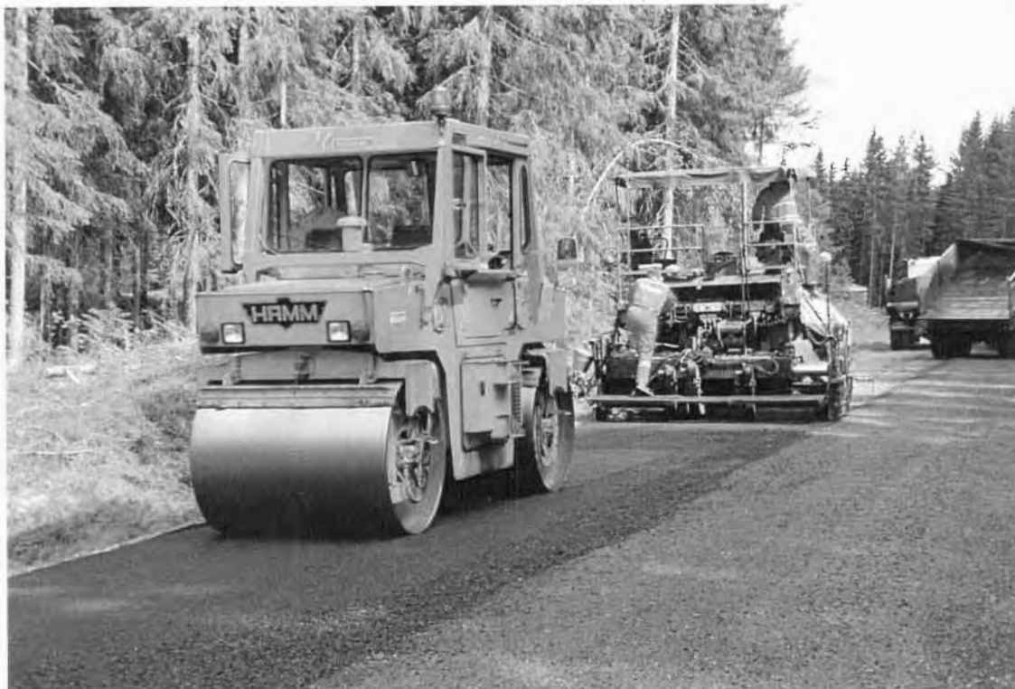
FIGUR 8 Valsing av nylagt Gja, Rv 200
