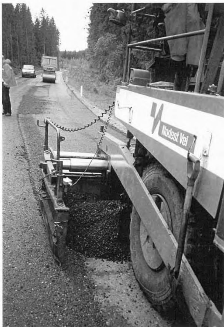
FIGUR 7 Utlegging av Gja, Rv 200
