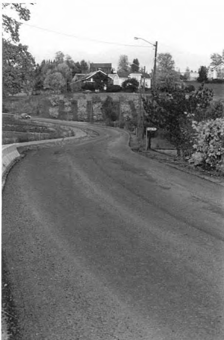
FIGUR 32 Dekke med kaldblandet Gja, Fv 21 Buskerud
