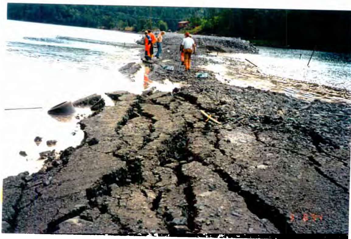
Figur 11. Inspeksjon av fyllingen. Det er ikke registrert setninger i fyllingen etter sprengningen. (Foto: Frestad/Pedersen, Statens vegvesen Vest-Agder)
