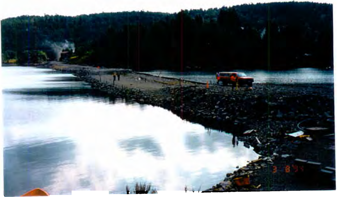
Figur 8. Rørene er satt ned og fyllingen er klar for sprengning. Rørene langs venstre fyllingskant er godt synlige. (Foto: Frestad/Pedersen, Statens vegvesen Vest-Agder)
