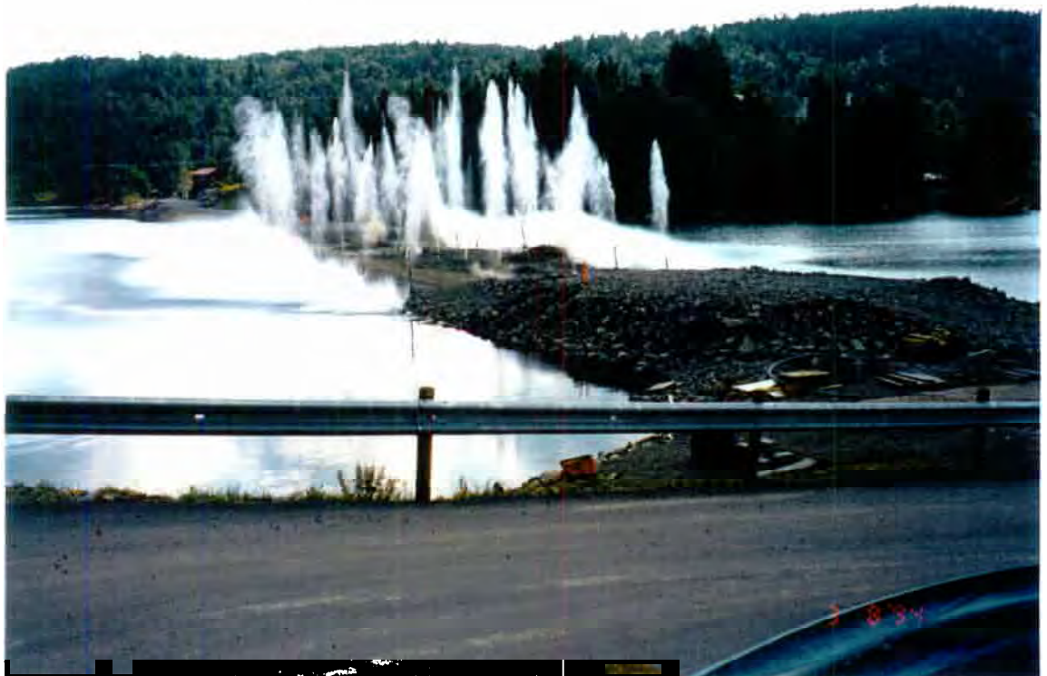
Figur 9. Sprengningsøyeblikket. For å redusere rystelser ble det brukt millisekundtennere og 1 rør pr. tennernr. (Foto: Frestad/Pedersen, Statens vegvesen Vest-Agder)
