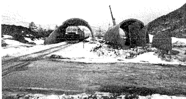
Figur 10 Betongelementtunneler før tilbakefylling
