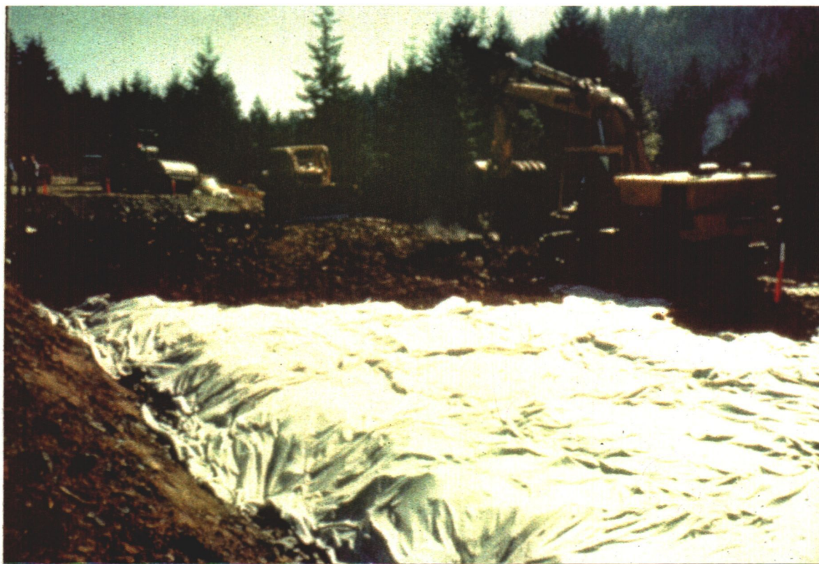
Figur 18. Utlegging av fiberduk over dekkbitene og oppbygging av overbygning
