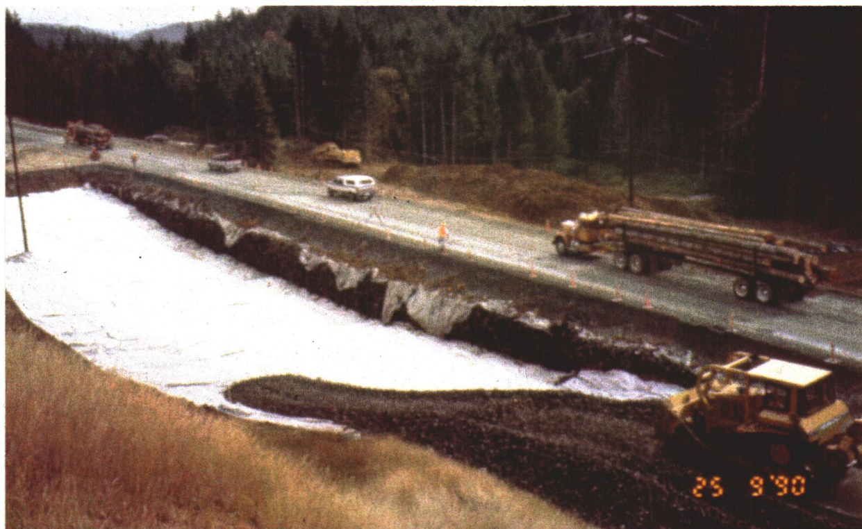
Figur 19. Veien er lagt over første del av bildekkfyllingen. Merk 3 m høy vertikal vegg i bildekkfyllingen.
