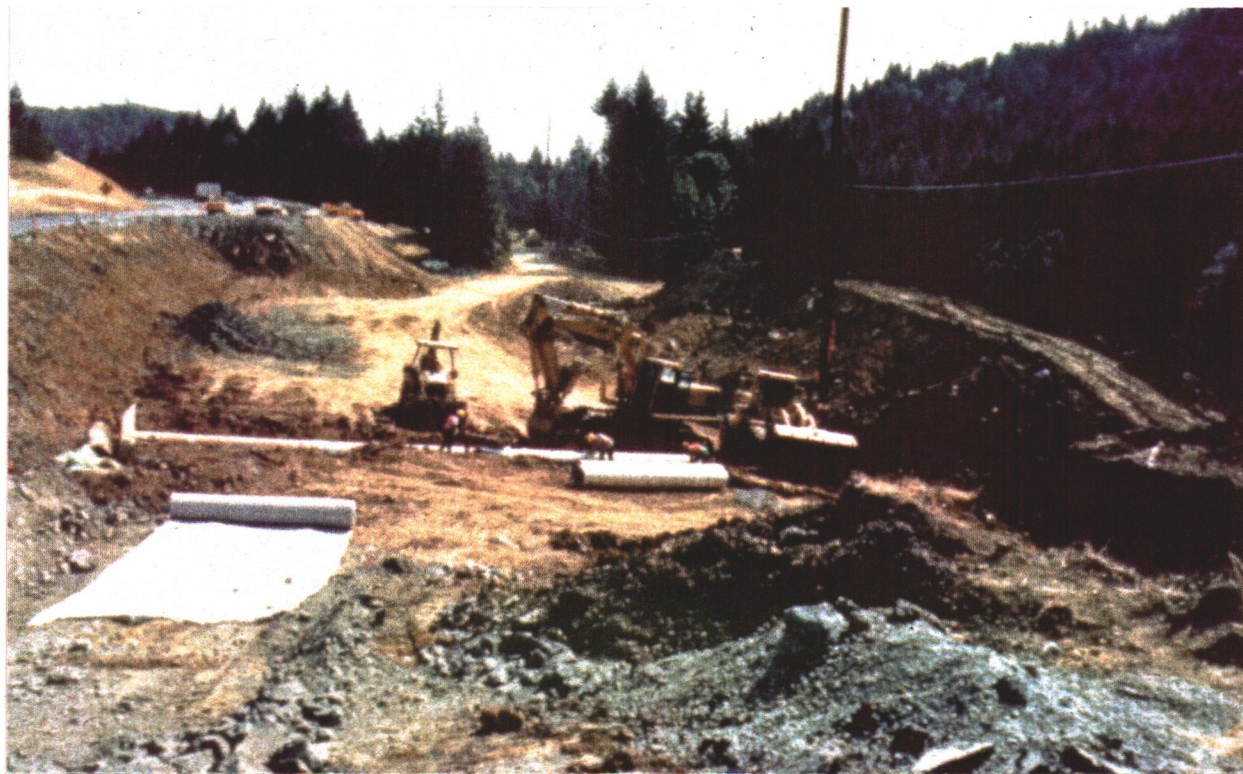
Figur 13. Utgraving og utlegging av fiberduk før oppfylling med dekkbiter
