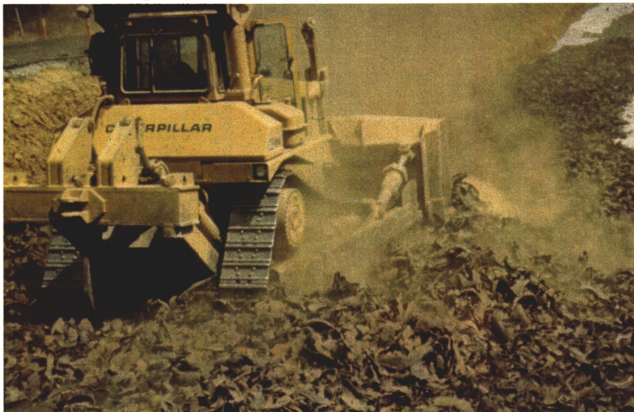
Figur 15. Utlegging med dozer
