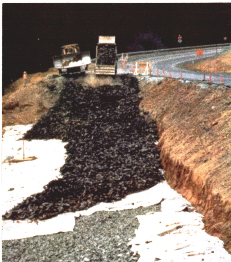
Figur 16. Oppbygging av fylling
