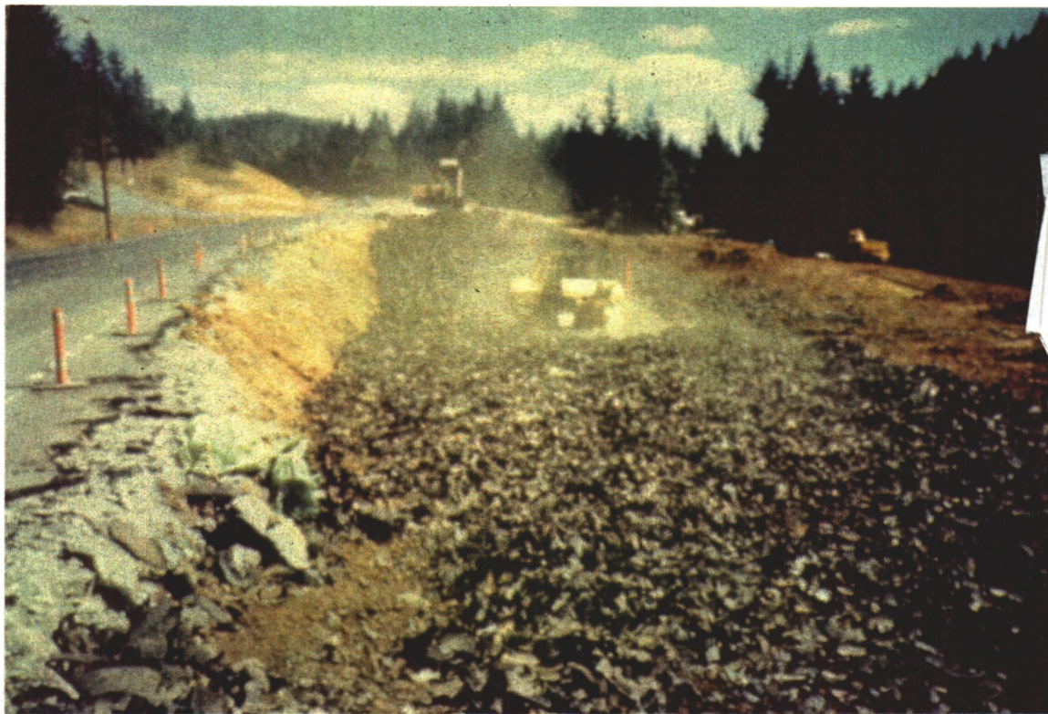
Figur 17. Komprimering av fylling med dozer
