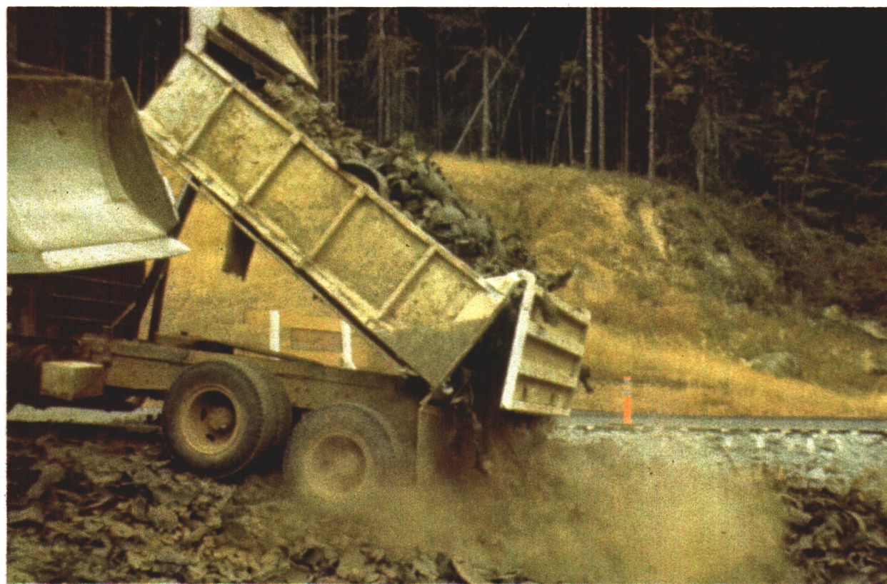
Figur 14. Tipping av dekkbiter
