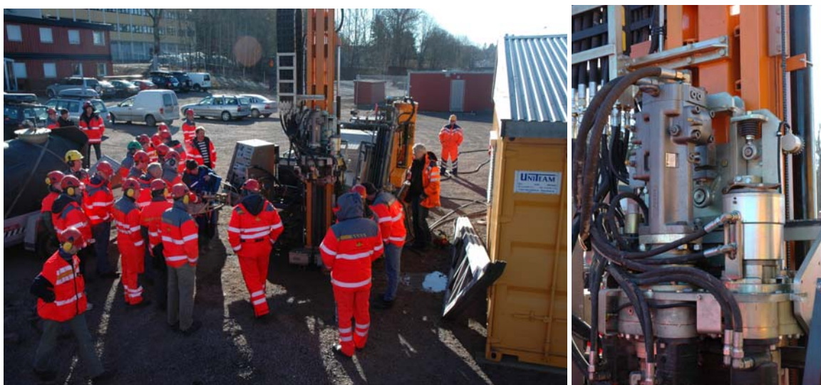
Bilde 2. Boring med ny borehammer
